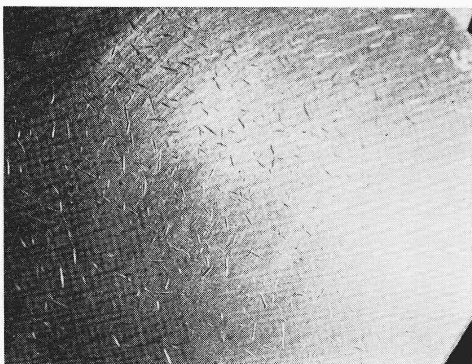
第 1 図 ポリエステルパテ系に生じたアクリルレジンエナメル のき裂状況
