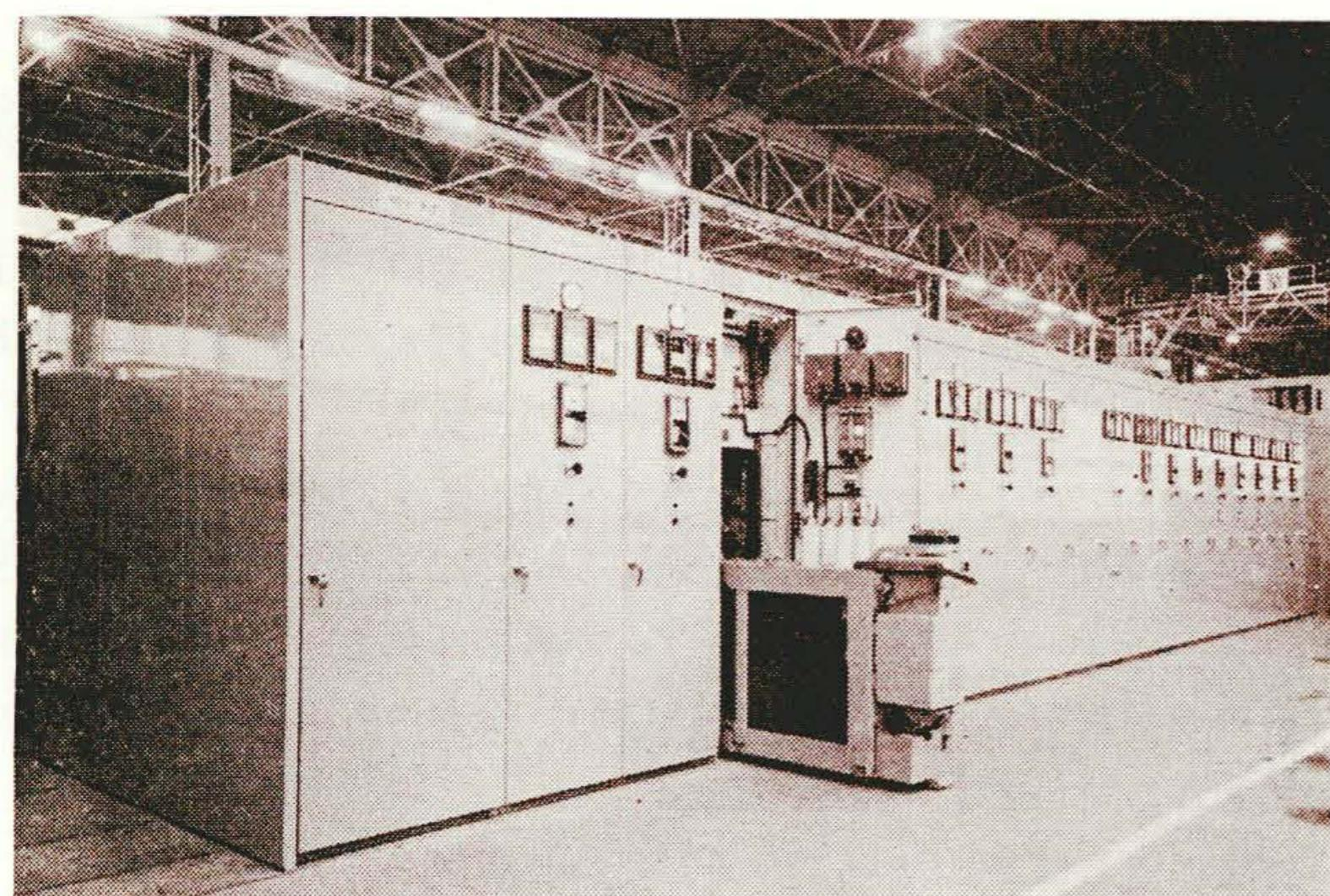
第4図 インド・ネロール発電所納 3.45 kV 高圧メタルクラッド配電盤
