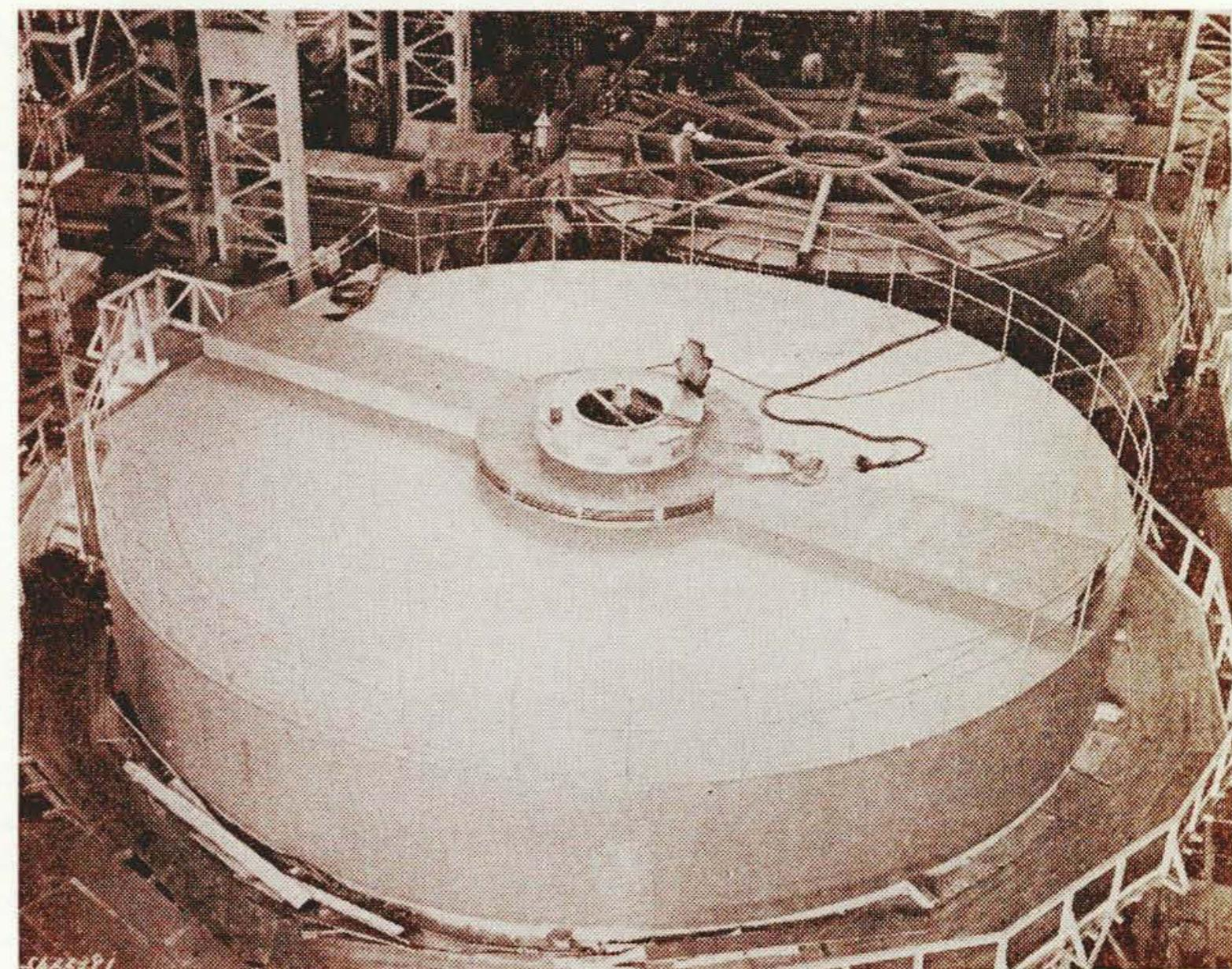
第2図 東北電力株式会社揚川発電所納 30,000 kVA 交流発電機
