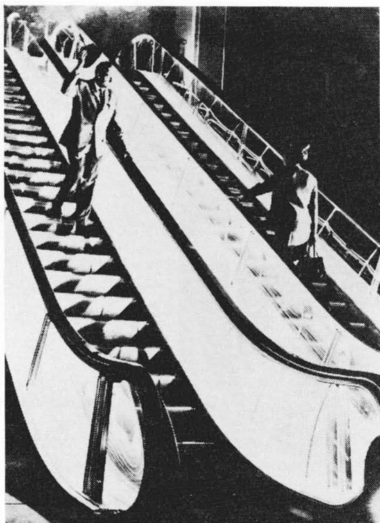
第24図 西ドイツカウフホフデパート納全透明式クリスタレータ
