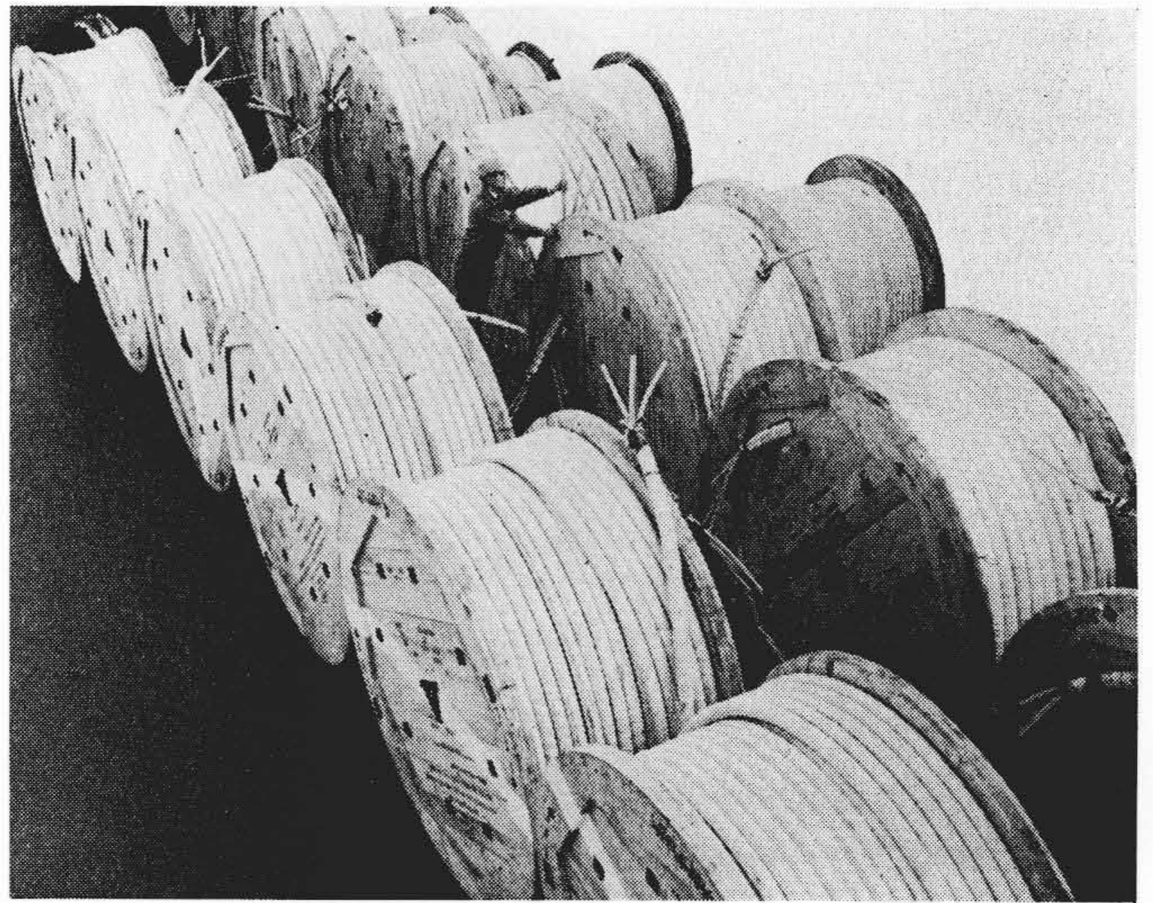
第 11 図 パキスタン向 11 kV ポリエチレン電力ケーブル
