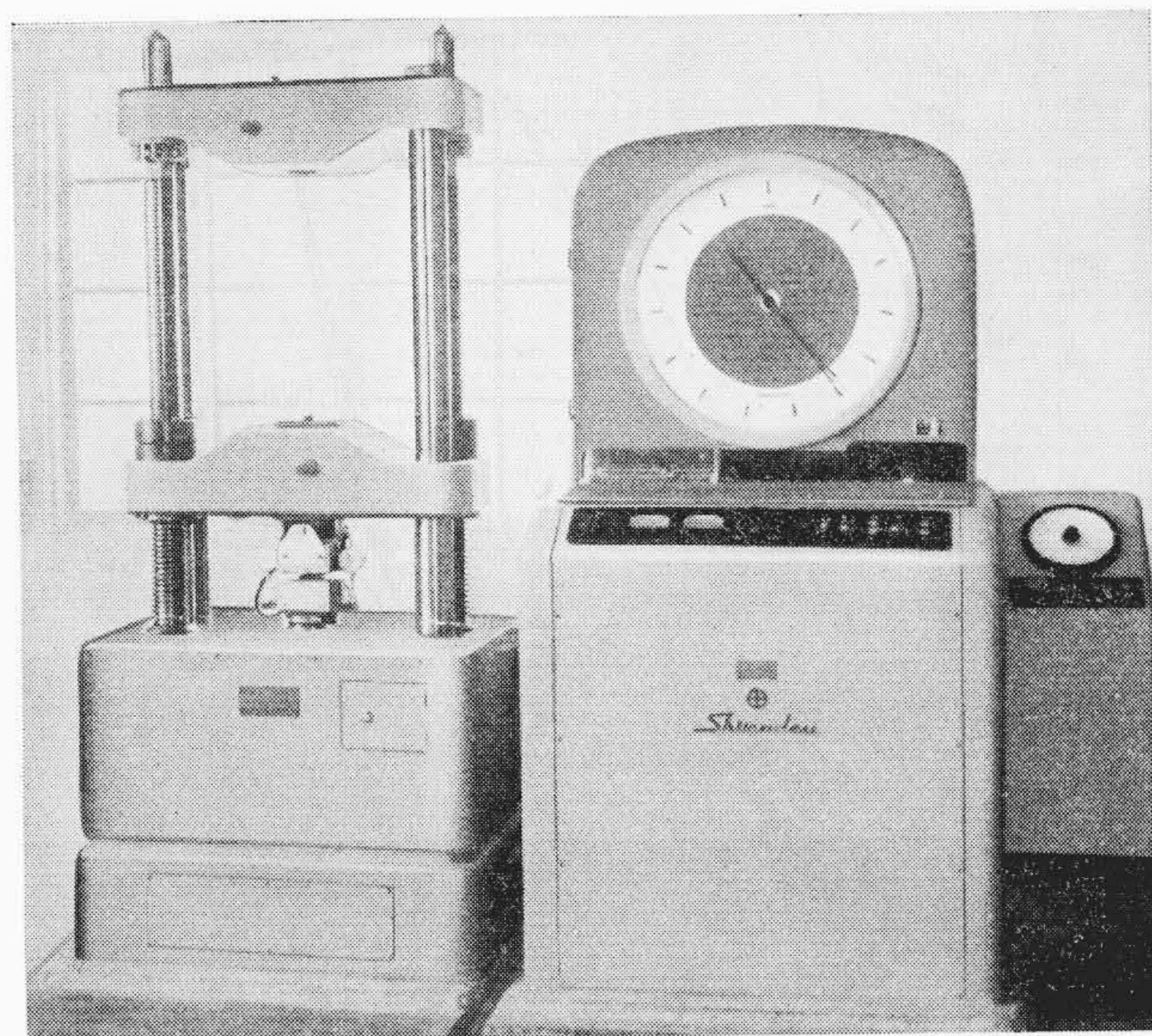
第2図 圧縮試験装置
