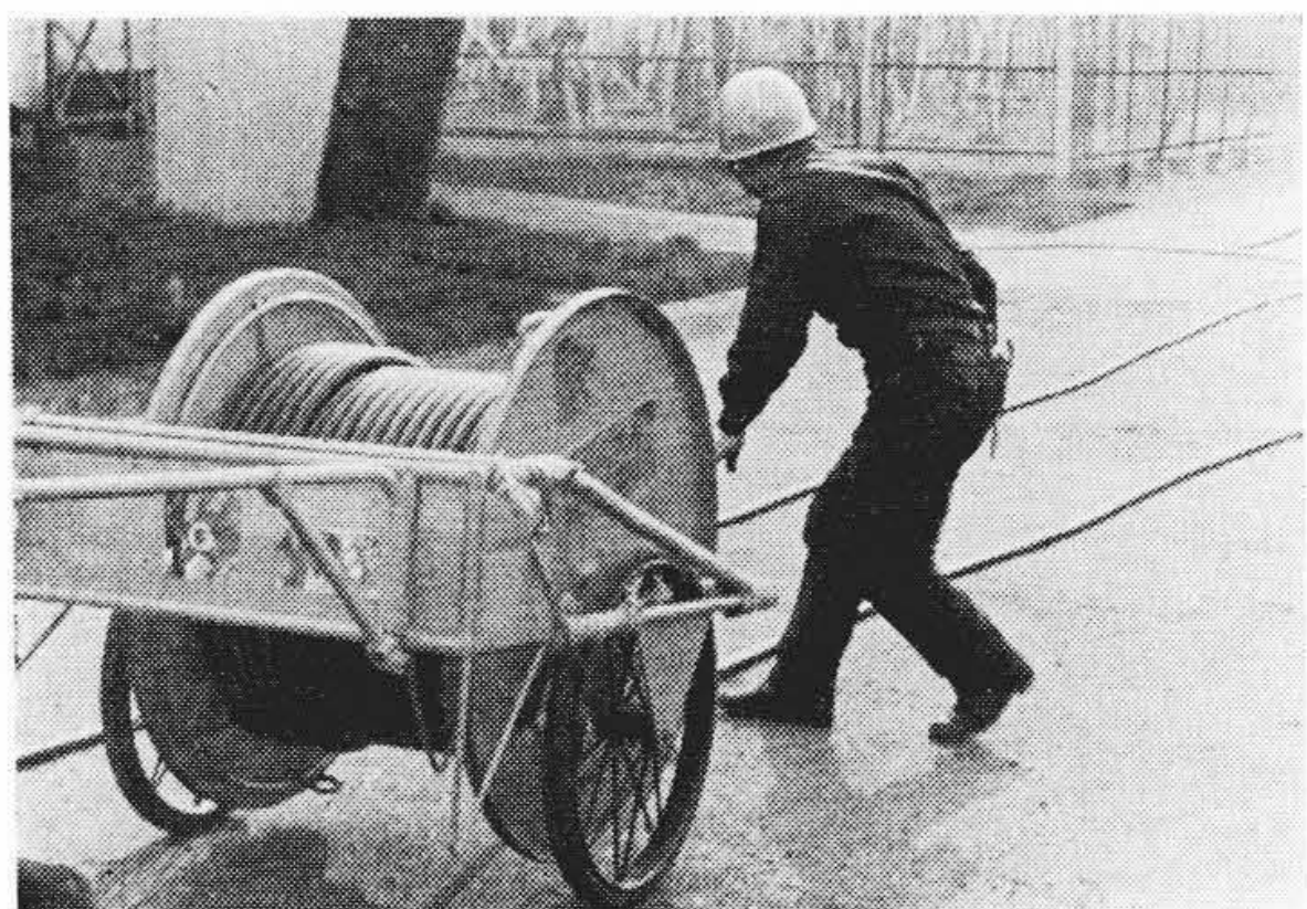
第6図 応急用ケーブル移動延線状況
