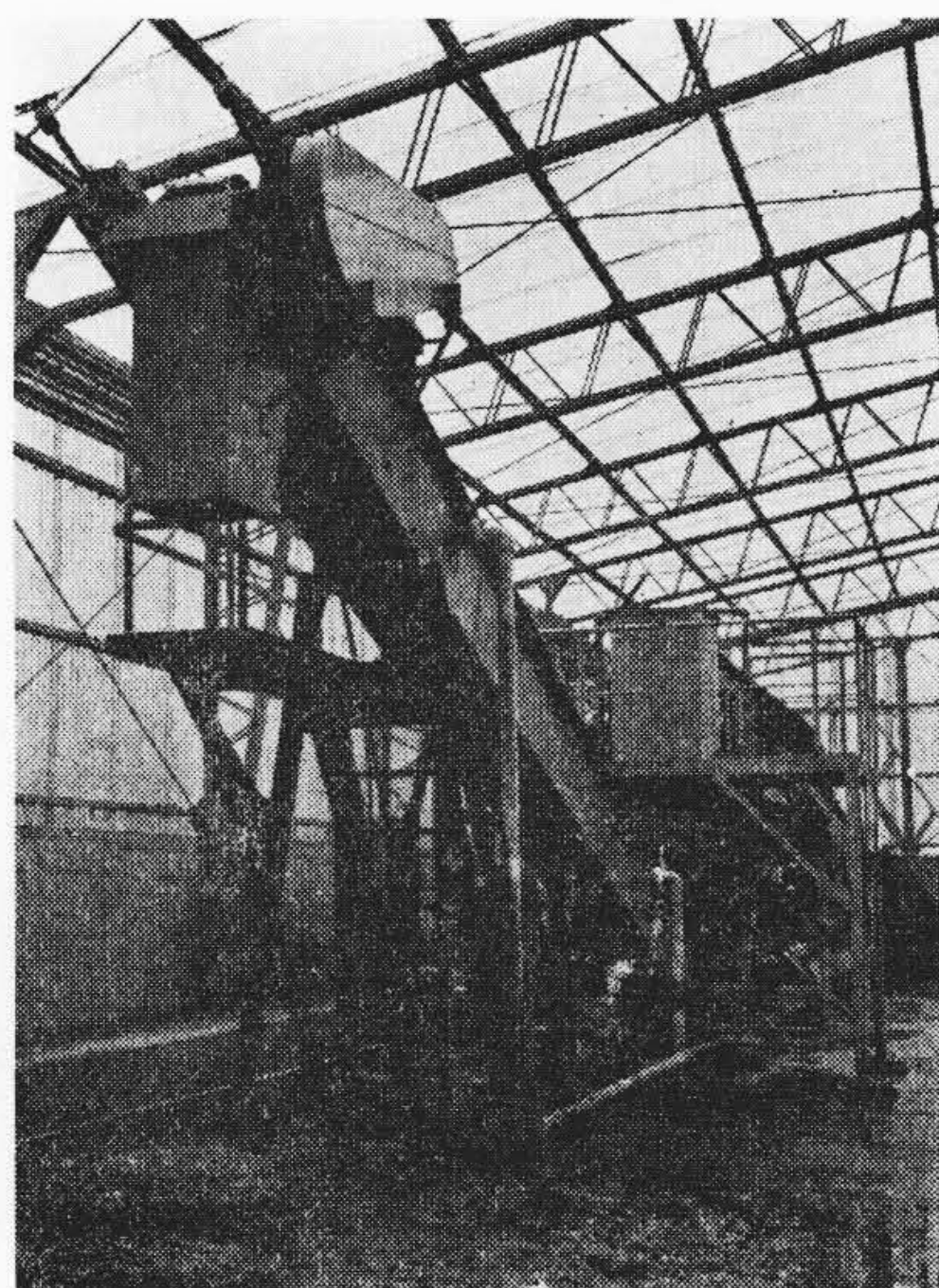
第10図 東京都，芝浦下水終末処理場納沈砂洗浄装置
