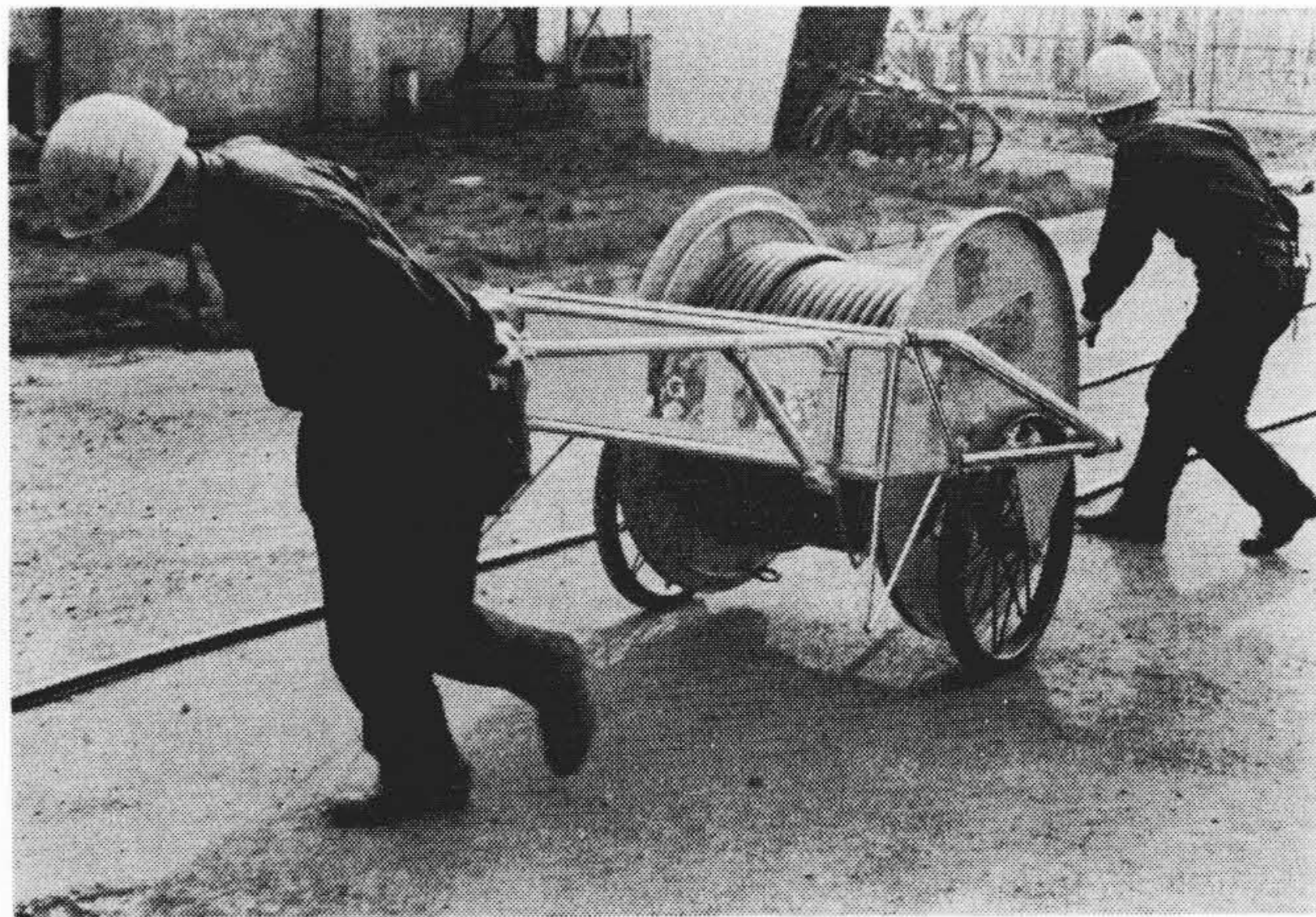
(応急ケーブル1相巻付普通形ドラム使用)
