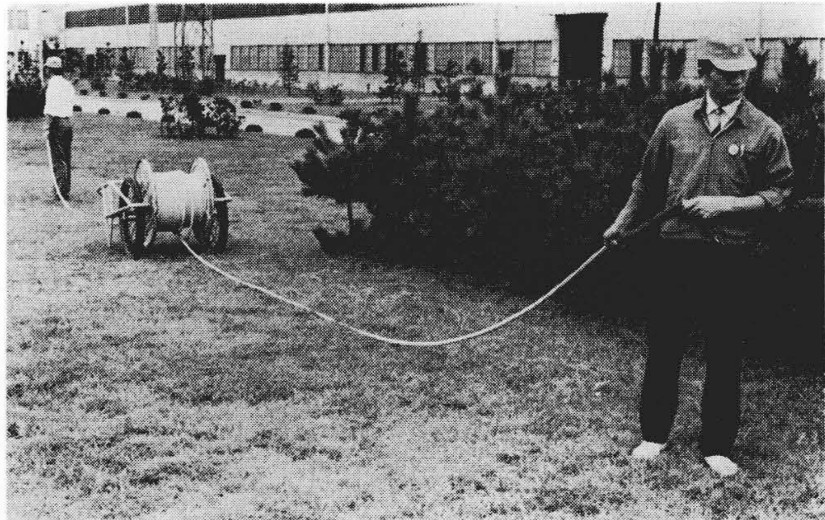
第12図 6.6kV バイパスケーブル用折り返し巻ドラムによる延線状況
