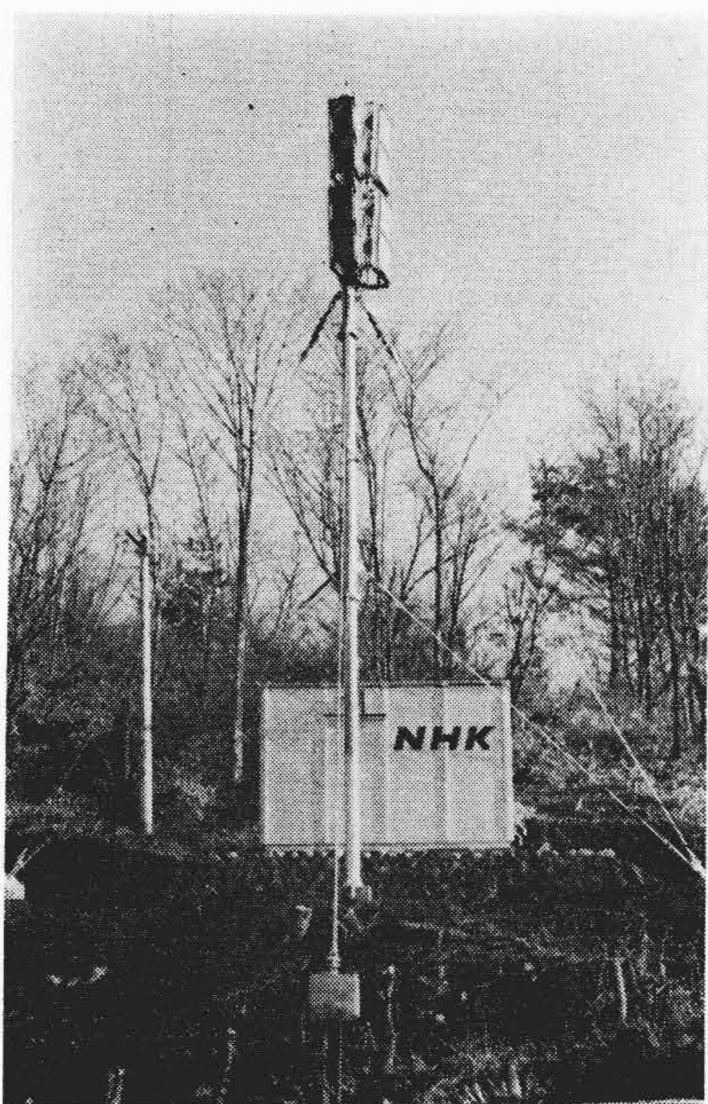
図11 NHK 倉本局送信用 90度コーナレフレクタ・アンテナ全景
