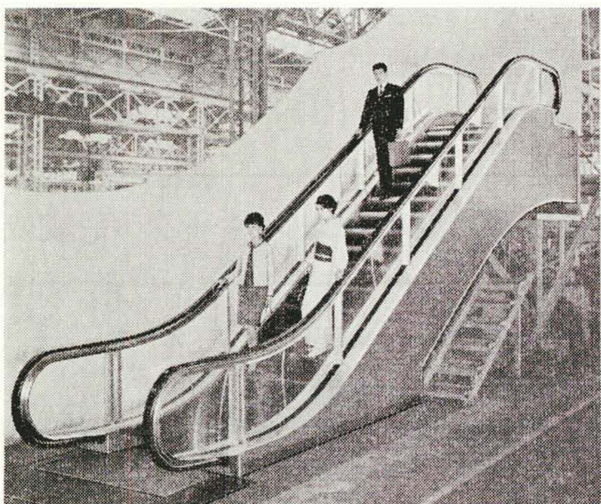
図18 1200C-NN形日立全透明式エスカレータ
