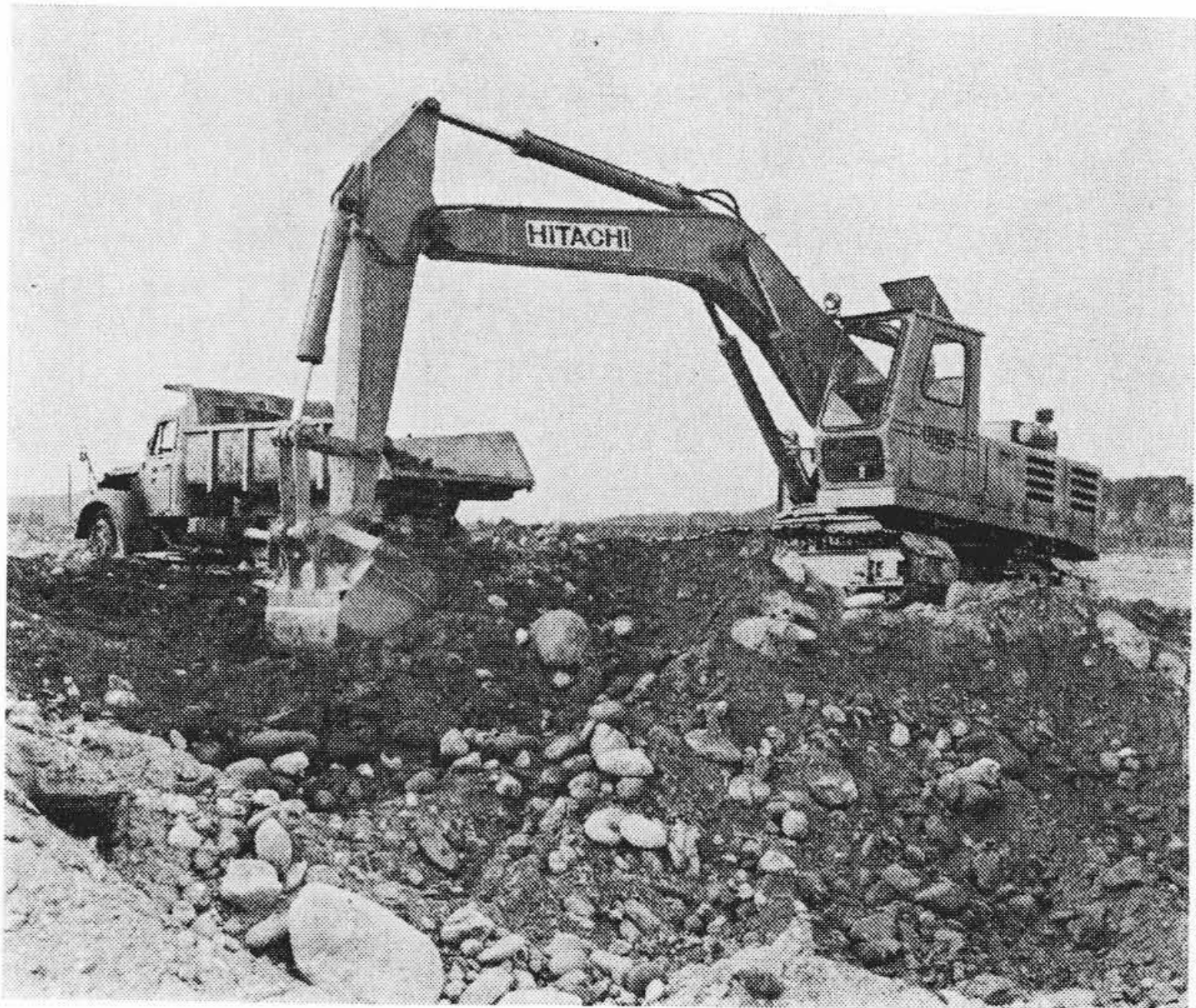
図1 日立 UH 06 油圧ショベル作業状況
