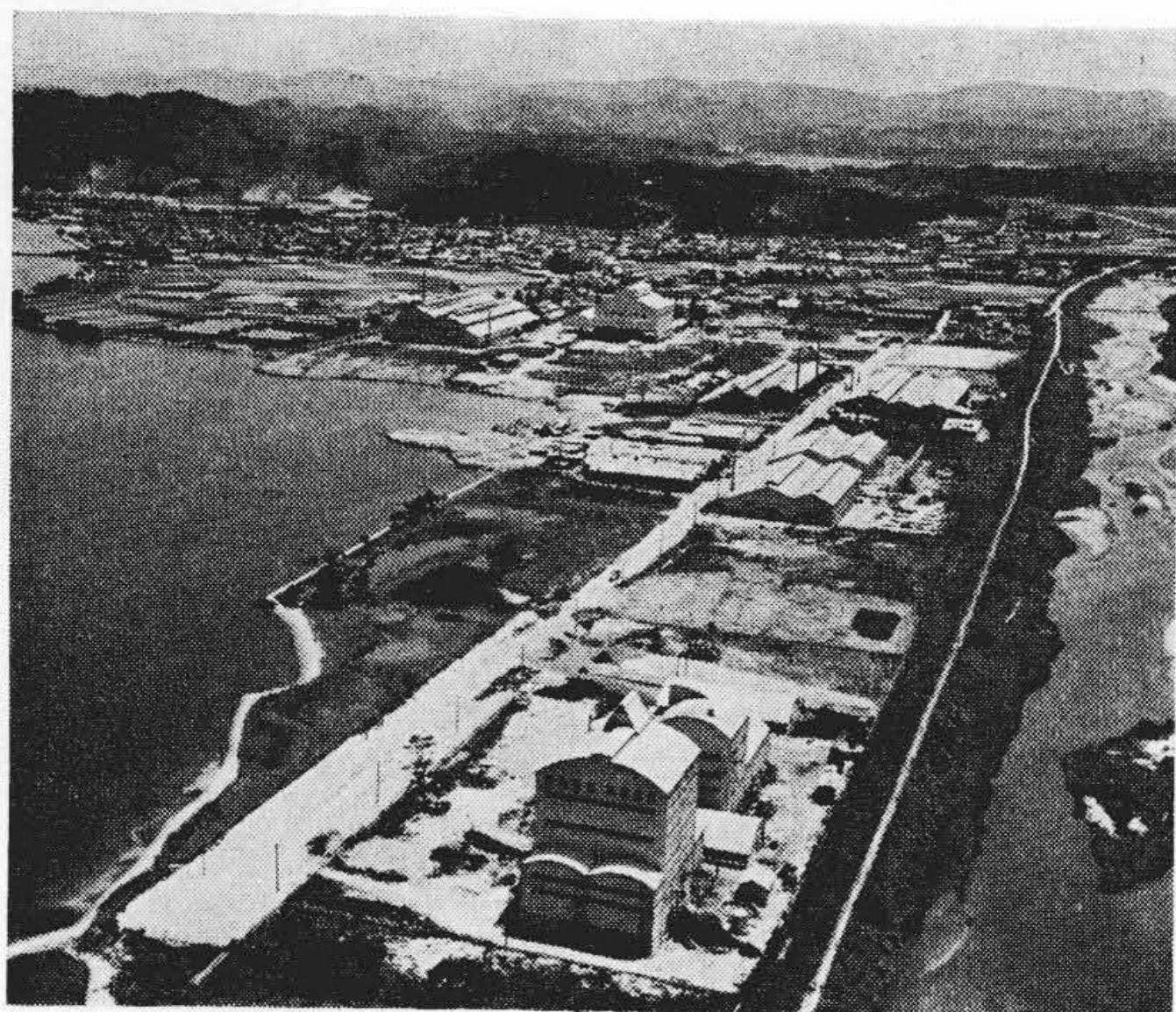
手前：海綿鉄炉建家 中央：ペレタイジング建家 先方：貯鉱および選鉱場
