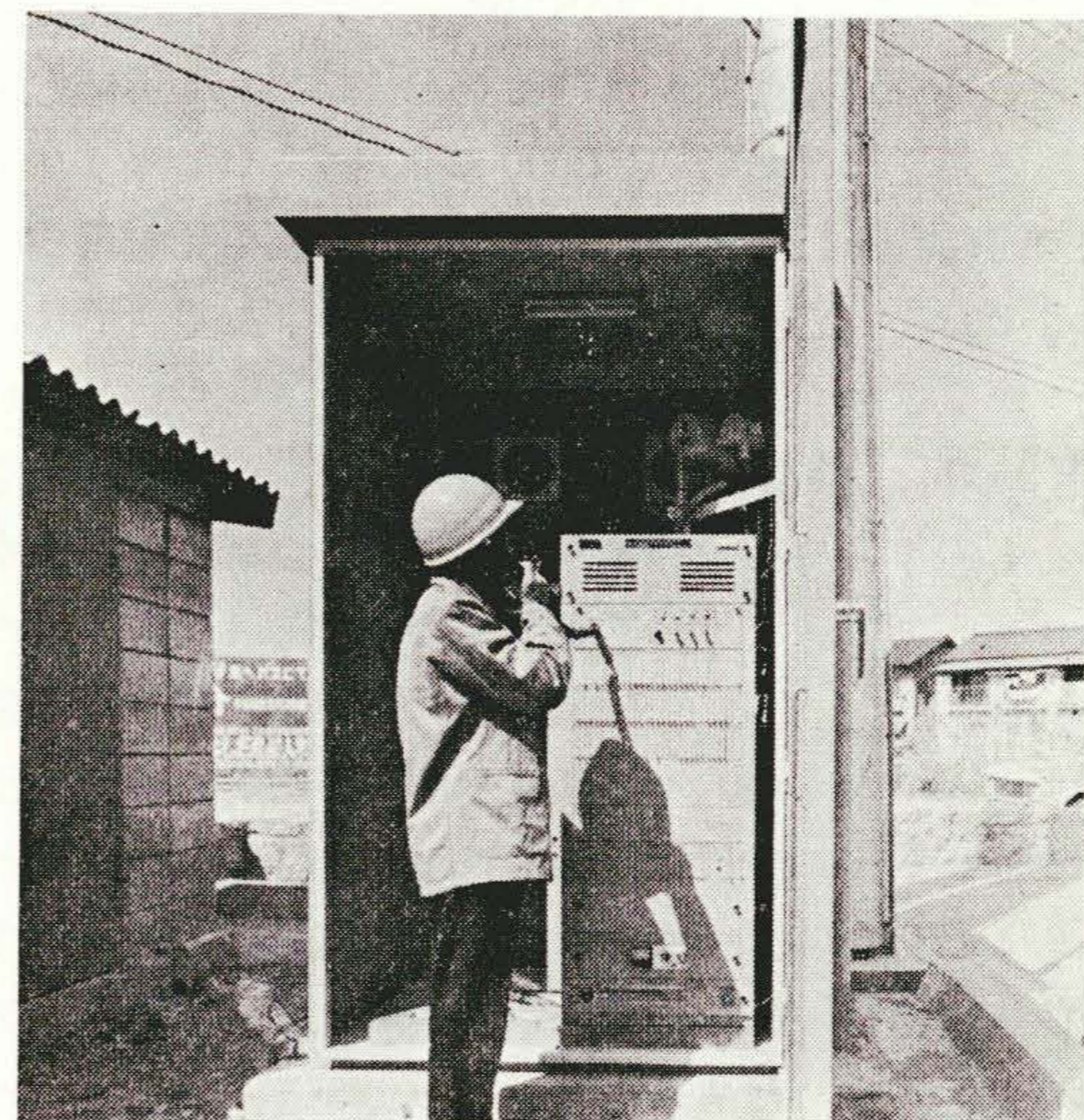
図8 東邦瓦斯株式会社納 計測データ通信装置(無線式子局)
