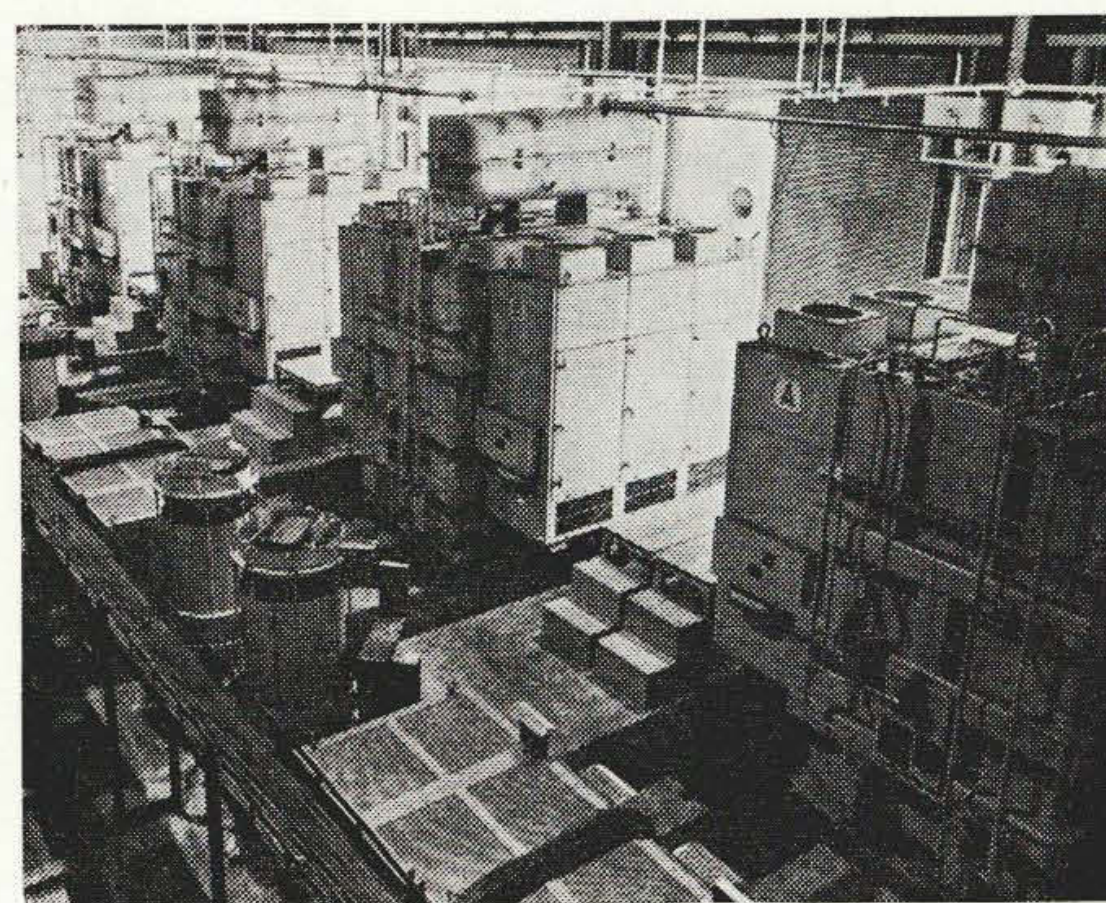
図30 56,000 kW 700 V 80,000 A サイリスタシリコフォーマ設備（アルミニウム製錬用）
