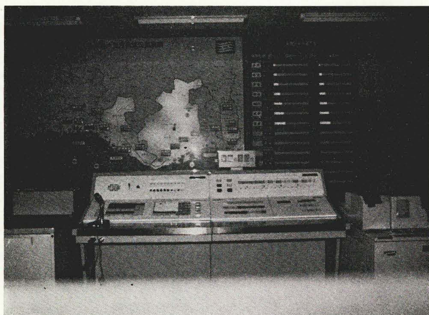
図5 計測データ伝送装置（兵庫県大気汚染監視システム）
