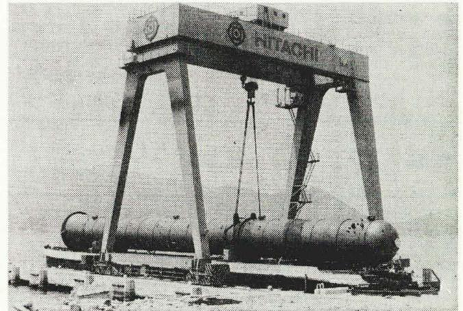
図11 船積み中の高張力鋼使用の大形塔
