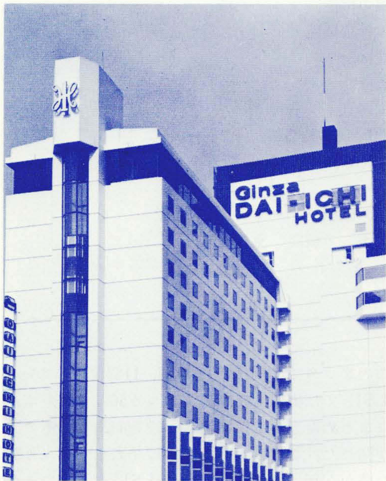
図5 展望用エレベータが稼働中の銀座第一ホテル
