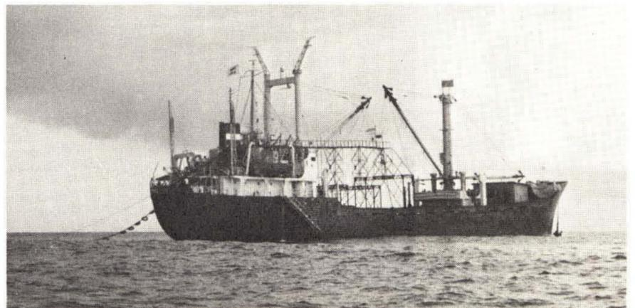
図2 海底ケーブルの布設状況
