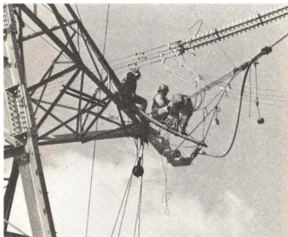
図3 プレハブ架線工事状況
