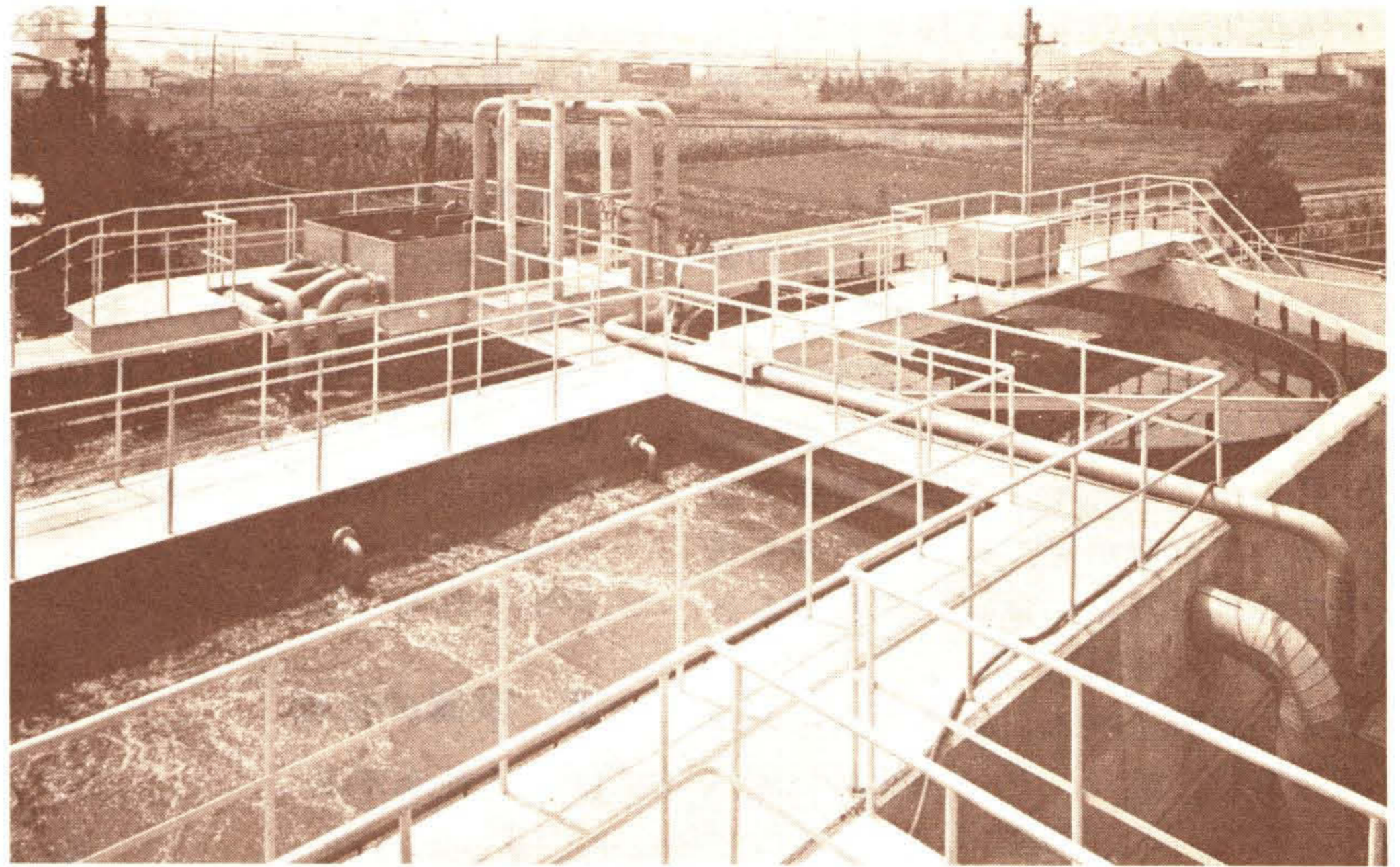
図1 廃水処理装置の全景
