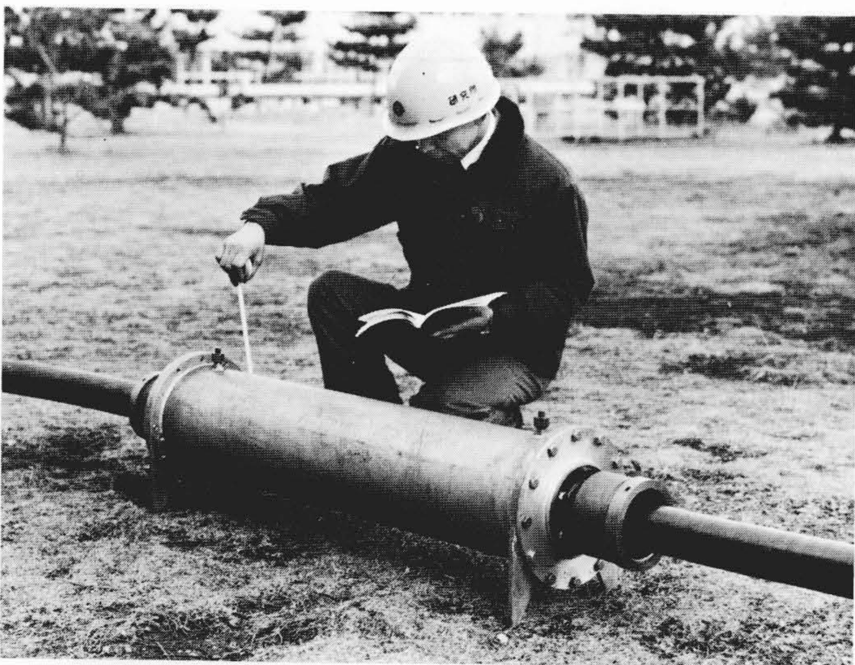
図6 油浸形直線接続部の組立状況 ケーブルの熱特性を考慮した補強絶縁層の採用により長期安定性が得られる。
