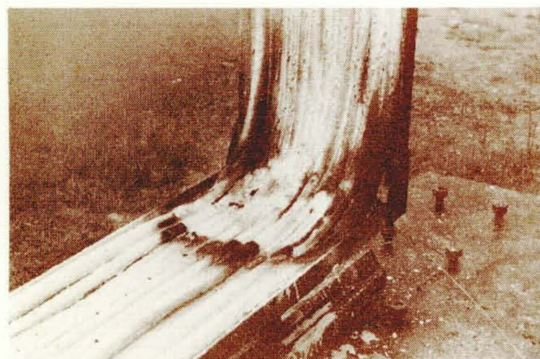
図 3 塗布し、燃焼15分後における状態
