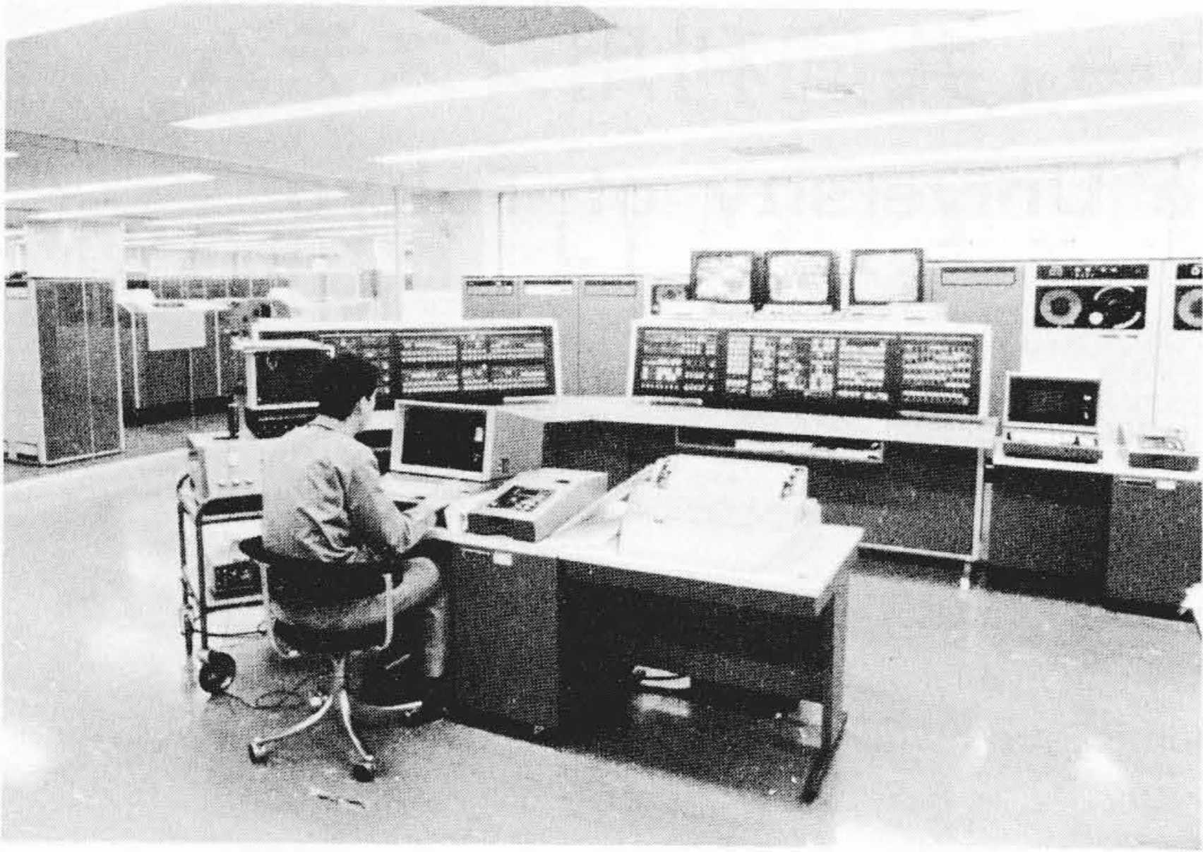
図1 HITAC 8800/8700システム 中央のオペレータ室では、オペレータ1名でシステム全体の運転を行なっている。
