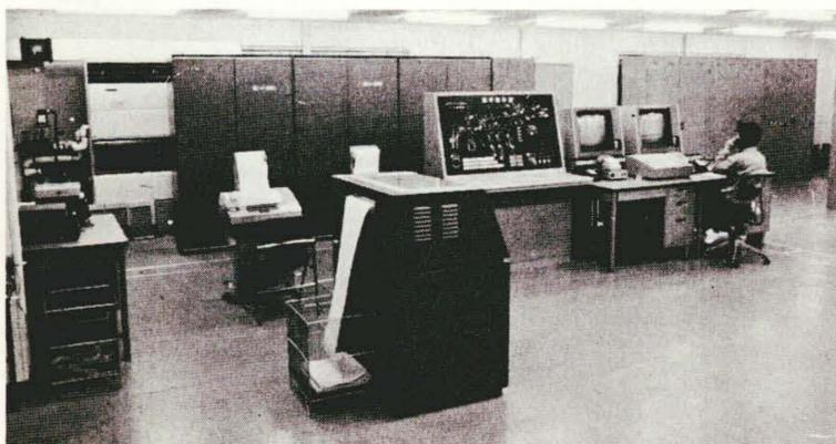
図17 製鉄所構内鉄道輸送自動化システム(中央制御室)
