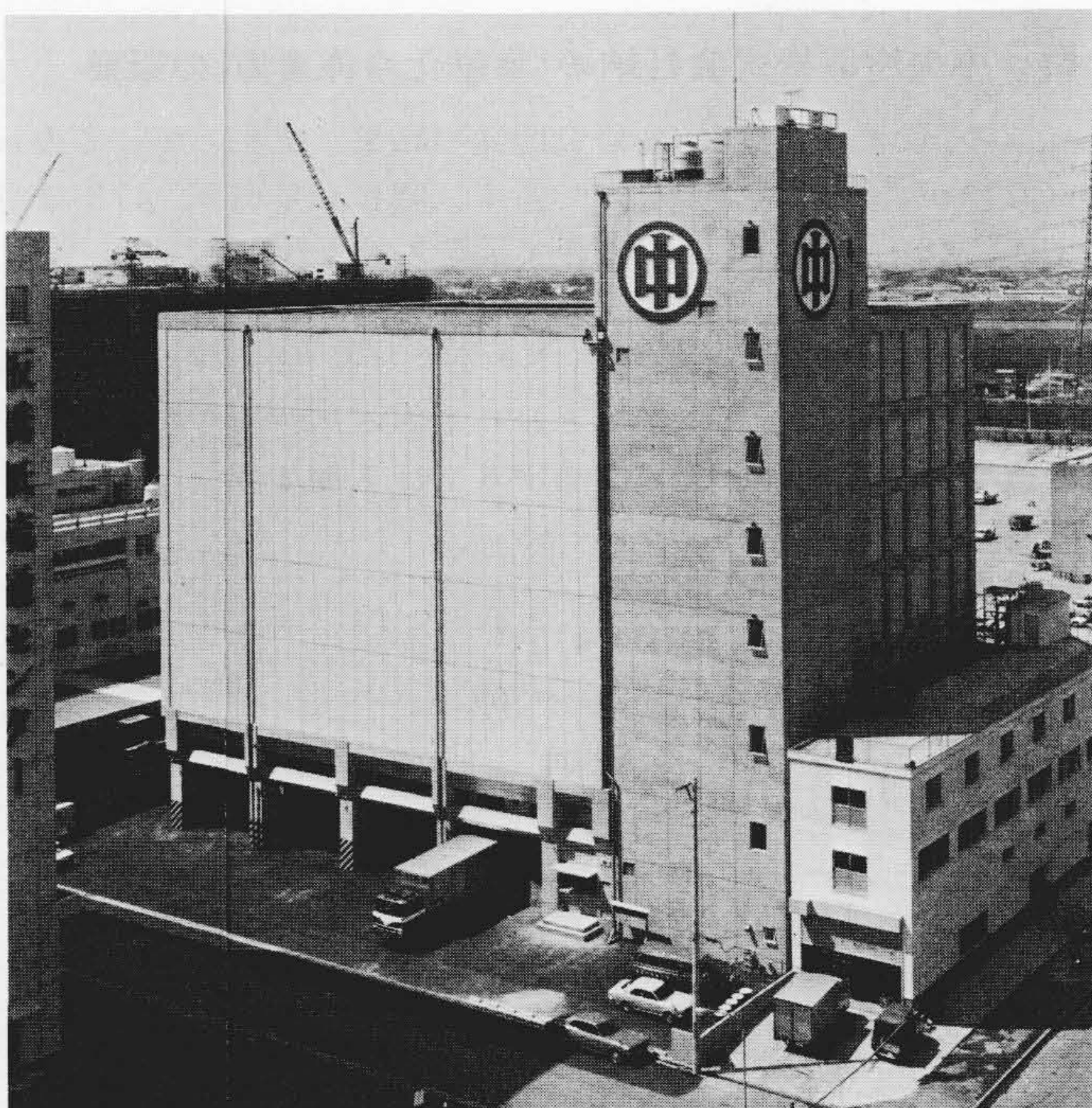
図1 自動化冷凍倉庫 東京都板橋区内に完成した自動化冷凍倉庫の全景を示す。
