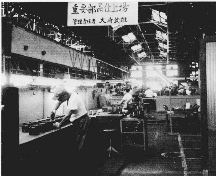
図8 重要部品仕上専門職場 重要部品仕上専門職場を示すもので、有資格者による重要部品仕上専門職場を設けて、作業不良の徹底的排除を図っている。
