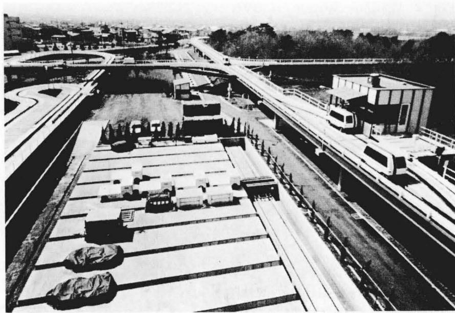
図 5 CVS車両とメンテナンス エリア付近の状況 東村山実験場におけるCVS車両外観とメンテナンス エリア付近のガイドウェイがわかる。
