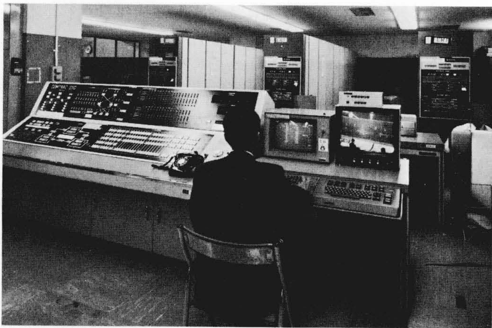
図7 進路制御系電子計算機 手前は、電子計算機の運転状況の監視、及び操作を行なうシステム コンソール、後方は3台のHIDIC 700処理装置を示す。
