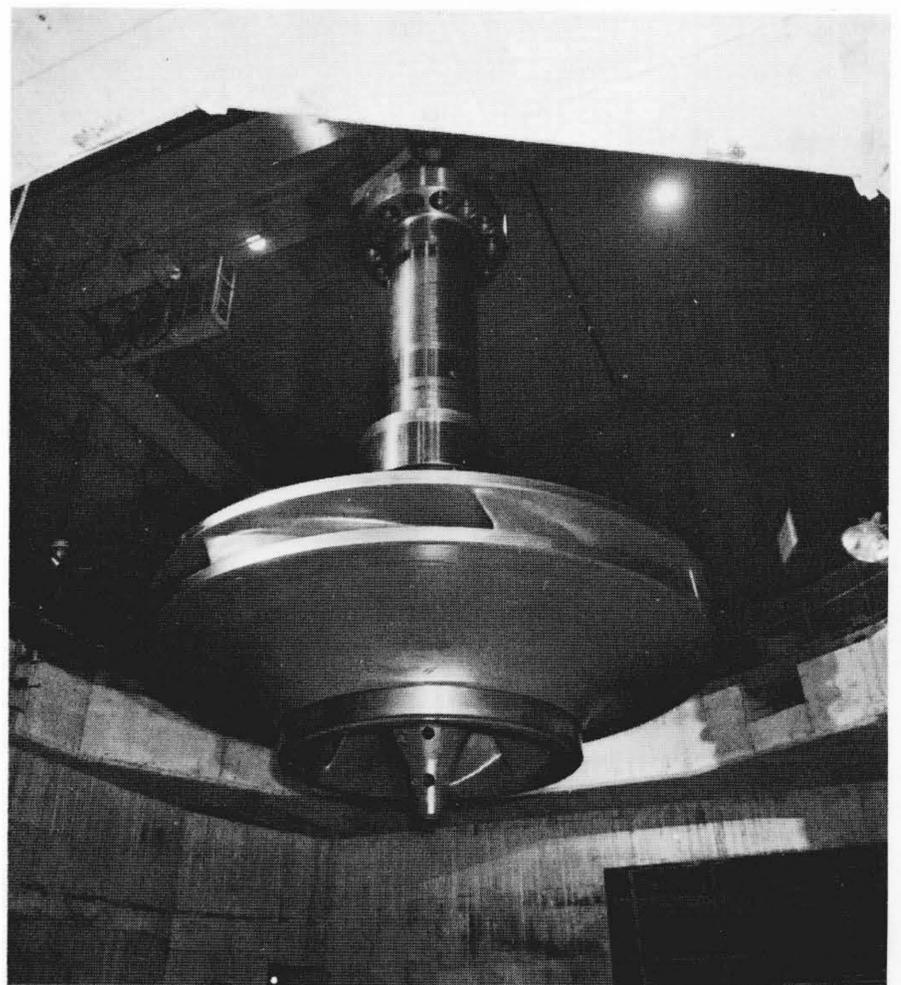
図4 256,000kW ポンプ水車ランナの組込作業 高落差ポンプ水車のため、飲口幅の狭い偏平ランナとなっている。
