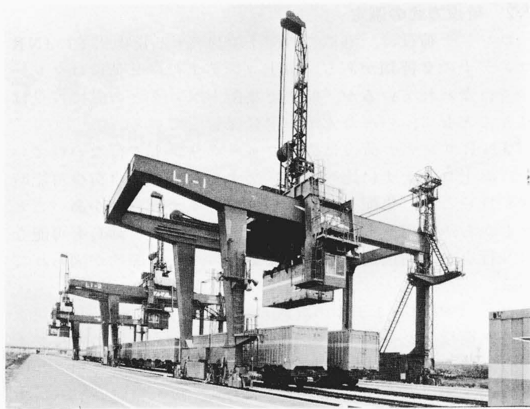
図1 5t, 10t 橋形自動コンテナクレーン JNR東京貨物ターミナル駅に据え付けられ、自動運転試験中の橋形自動クレーンを示す。
