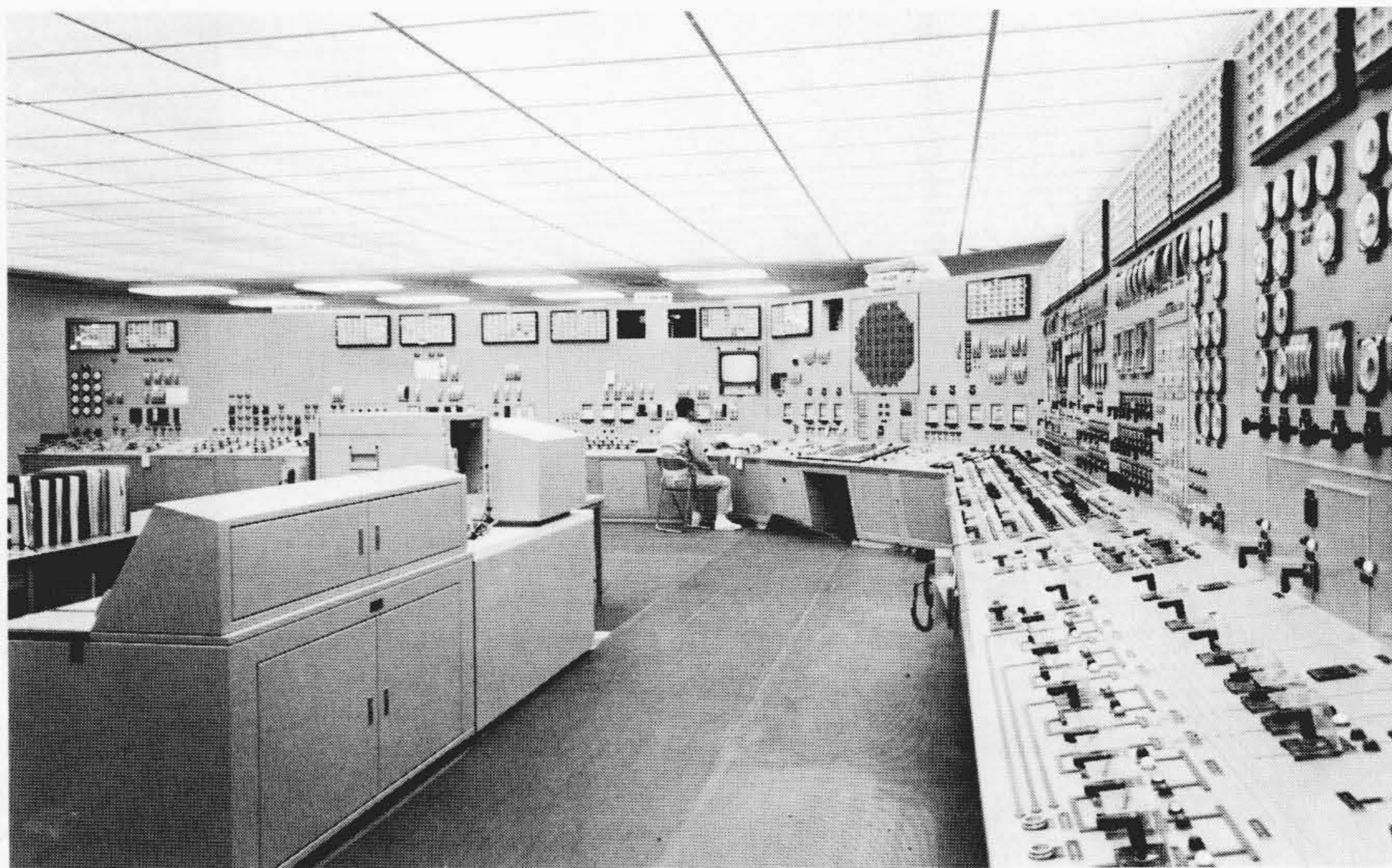
図3 日本原子力発電株式会社東海第二発電所納め中央制御盤
