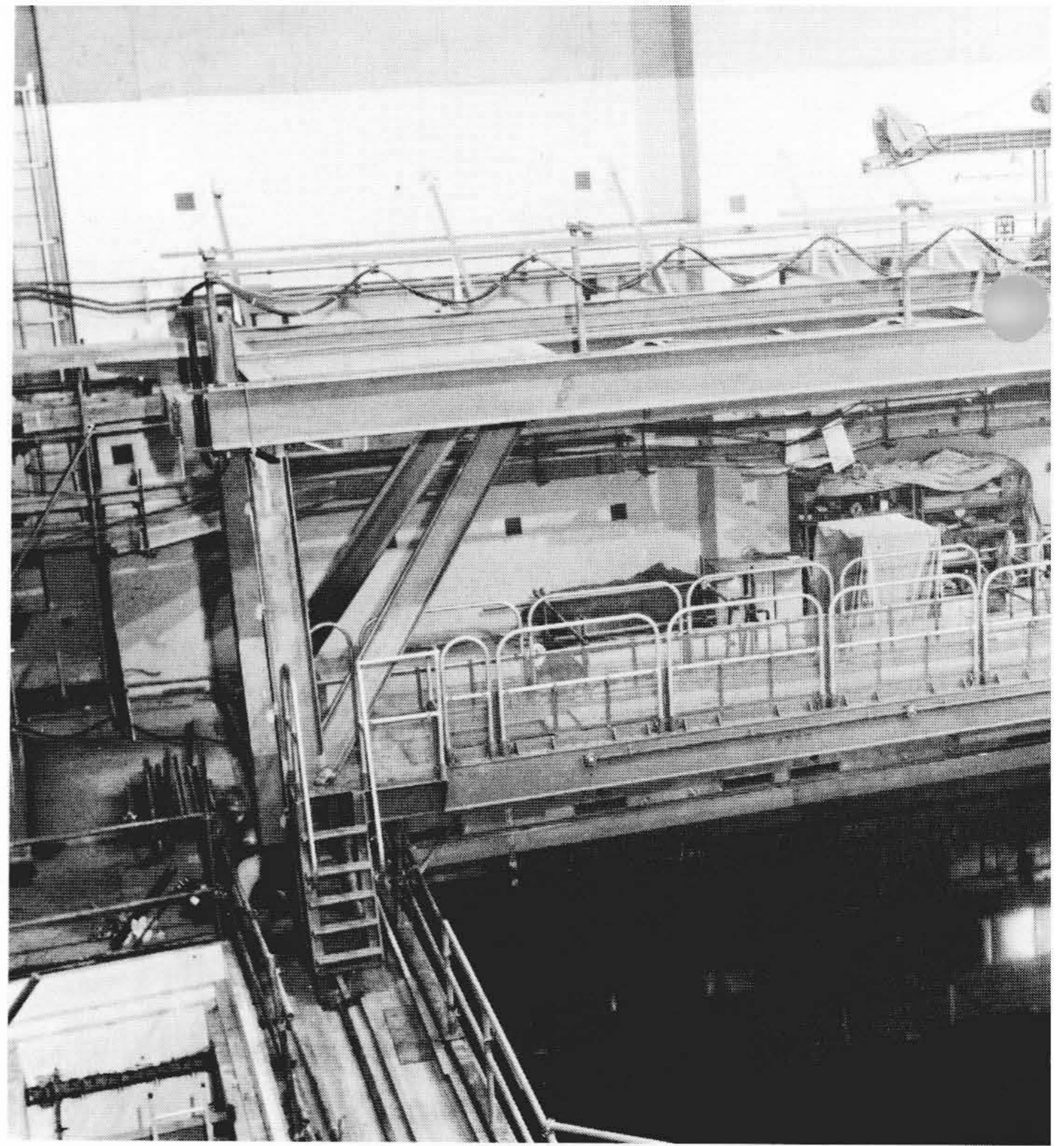
図6 自動燃料取替装置
