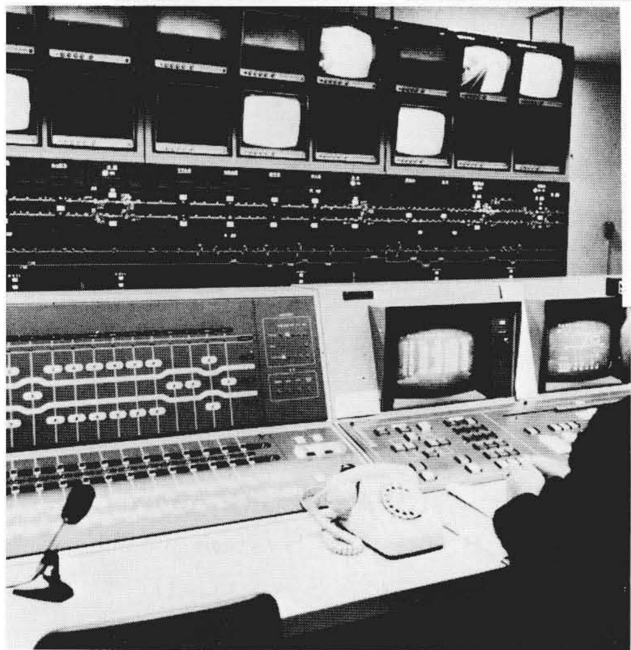
図22 札幌市地下鉄東西線運転指令室
