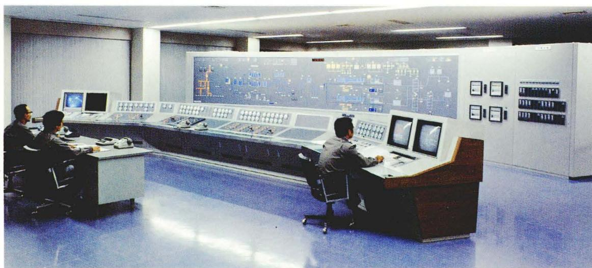
(2) 各子局からの信号、情報は中央監視室に集められる。中央監視制御装置には日立AQUAMAX-80シリーズが採用され、データ集約盤、多心ケーブル、プラグインリレーユニットなどの採用により、高密度実装、システム信頼度の向上が図られている。
