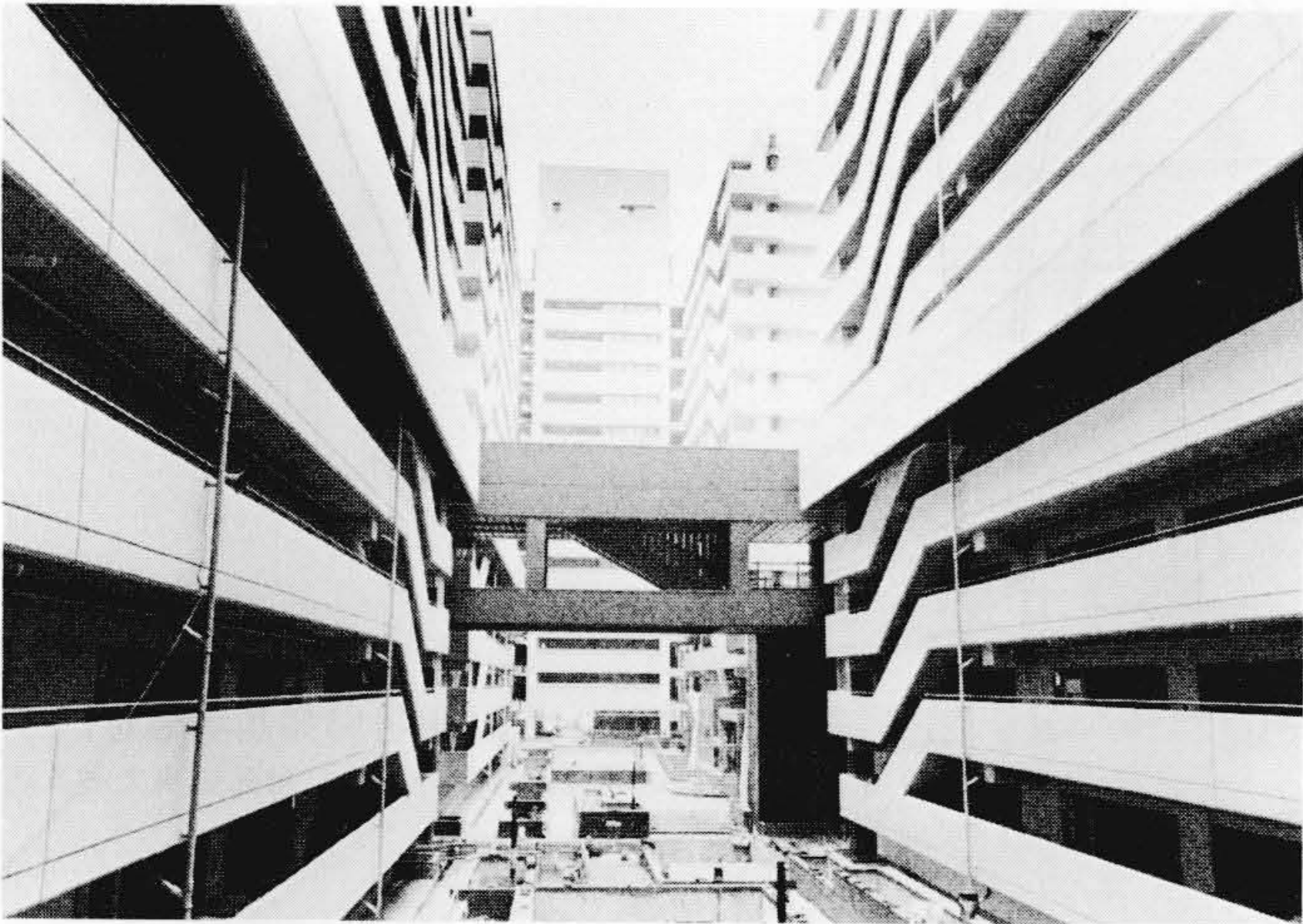
図2 白鬚防災拠点の住棟 完成した早期着工住棟は、関東大震災級の地震に耐えるように耐震設計されている。
