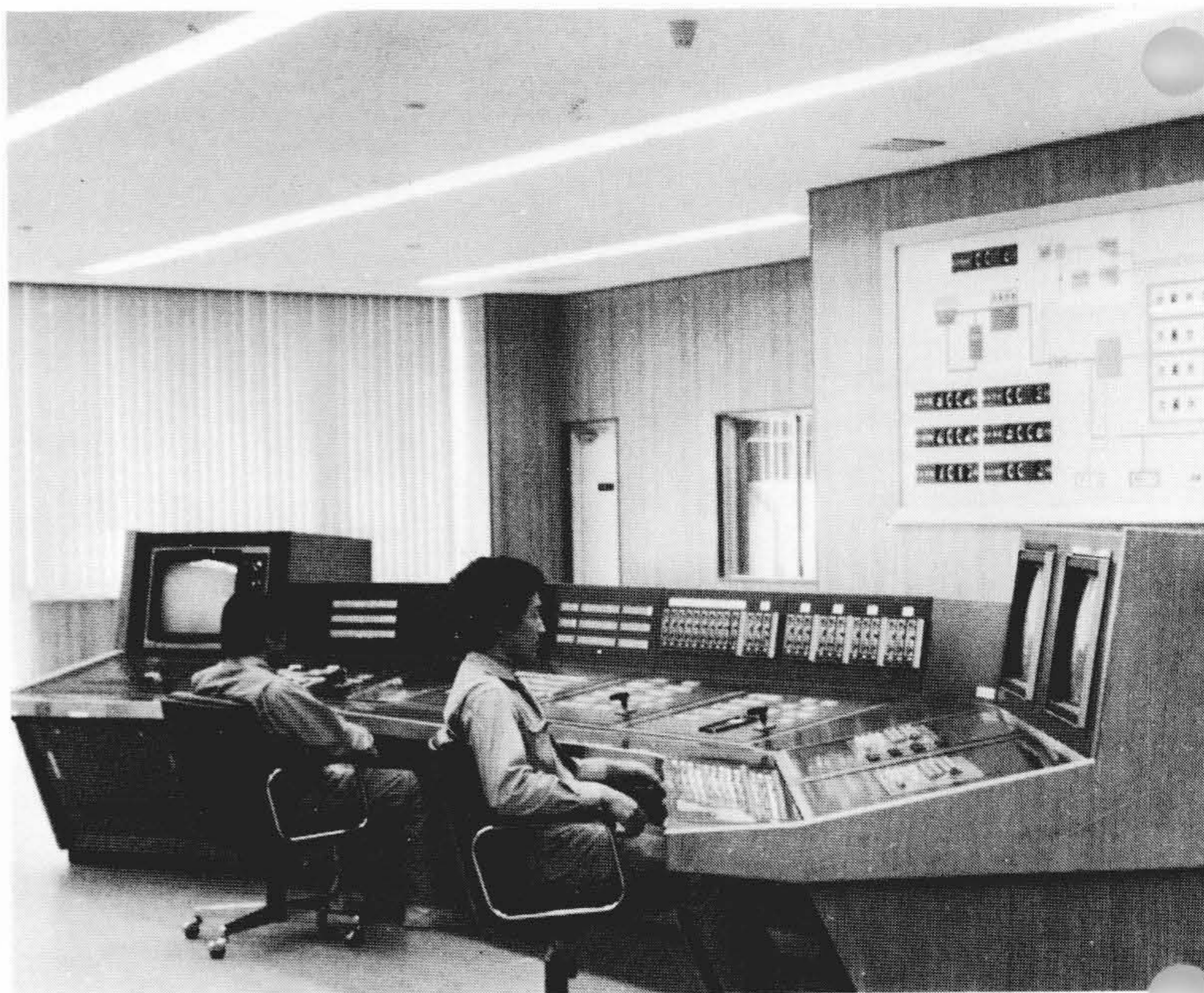
図1 中央監視制御盤
