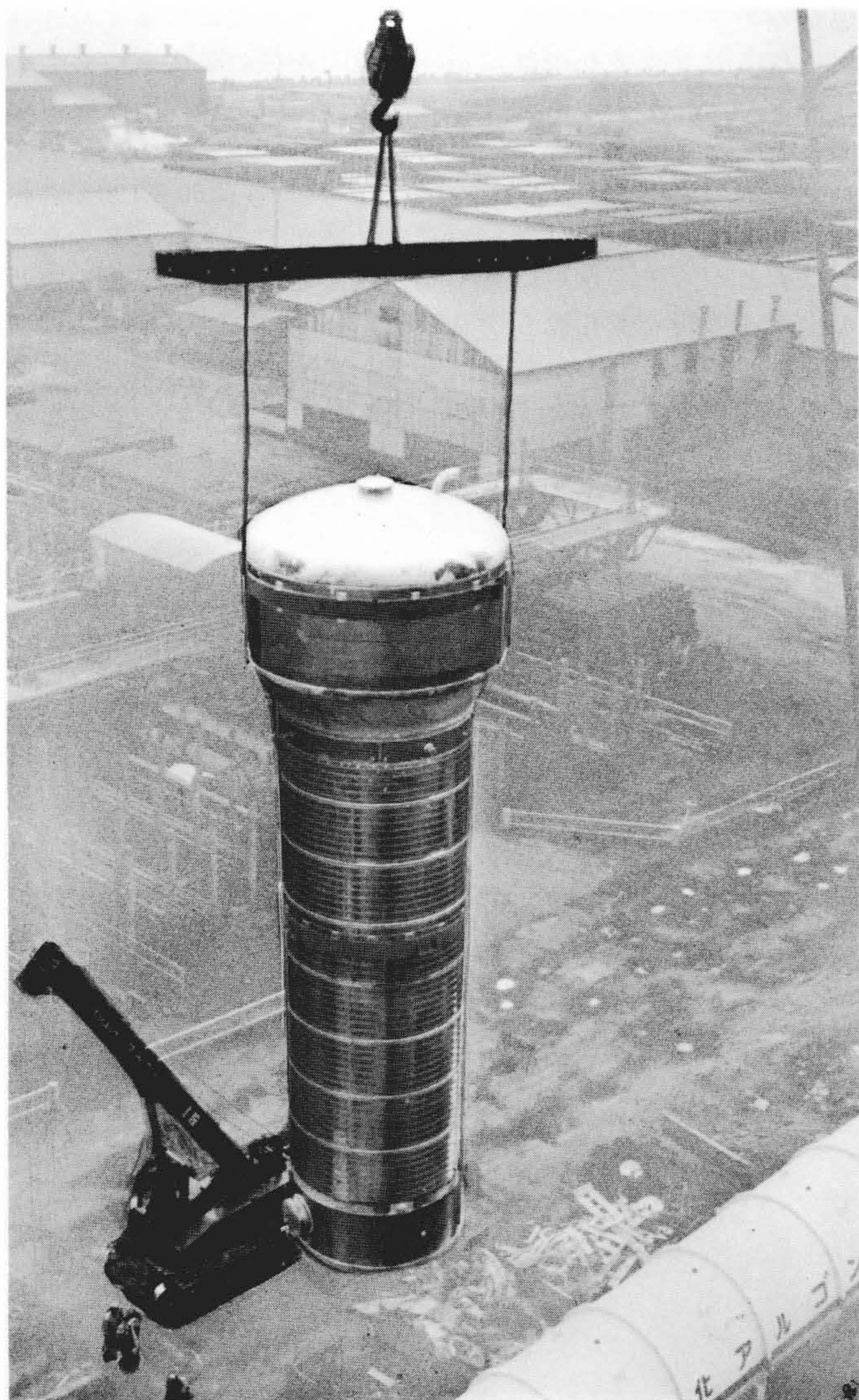
図8 粗アルゴン塔 据付のためつり上げられた粗アルゴン塔を示すもので、アルゴン製造容量 400 \text{ N} \cdot \text{m}^3/\text{h} 用のものである。
