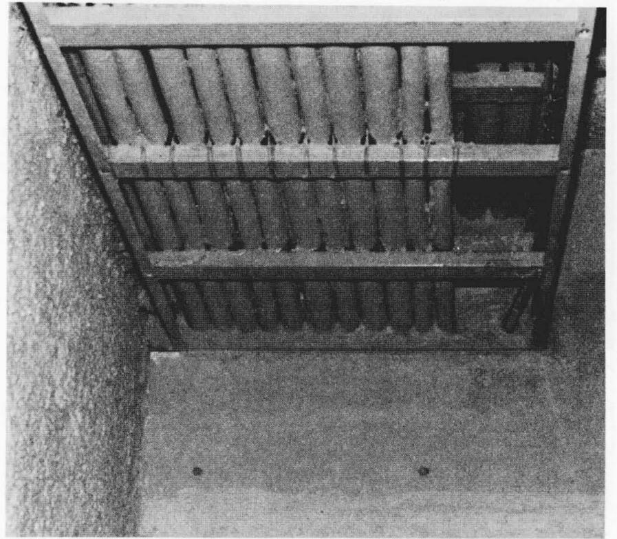
図7 壁貫通部の防火シール ケイ酸カルシウム板、ロックウール及びハイシールを用いて防火シールし、ケーブルにはフレイムマスチック®を塗布している。
