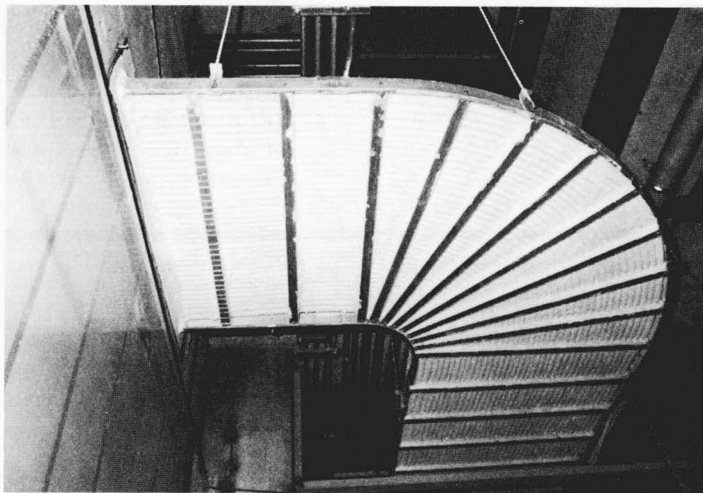
図6 天井ラック布設ケーブルの延焼防止塗料施工 フレイムマスチック®(スプレアブル)をスプレー塗布したもので、この場合ケーブルの上下に塗布されている。
