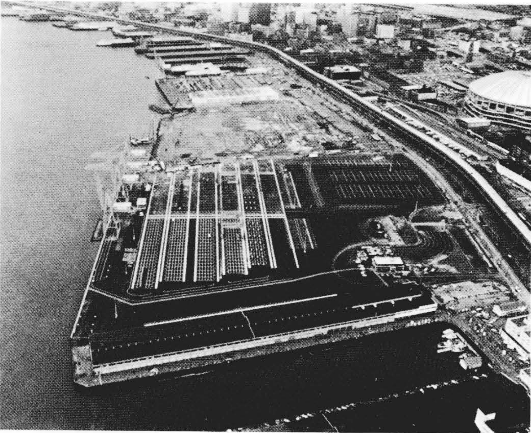
図2 POSコンテナターミナルの全景 岸壁用コンテナクレーン、トランスファークレーンの据付も終わり、開港間近のターミナルの全景を示す。
