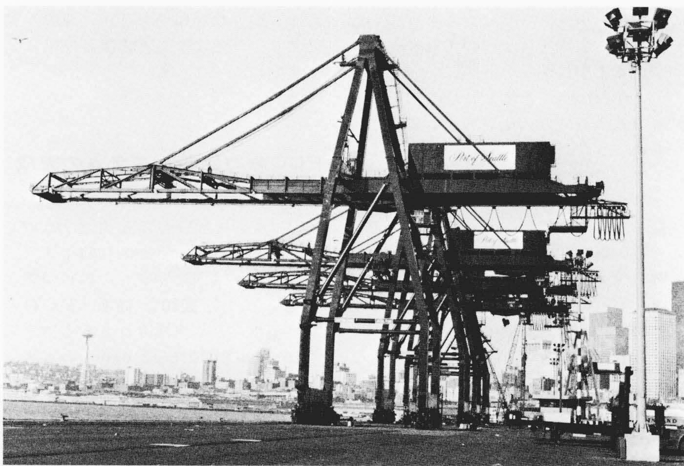
図29 振れ止め装置付コンテナクレーン
