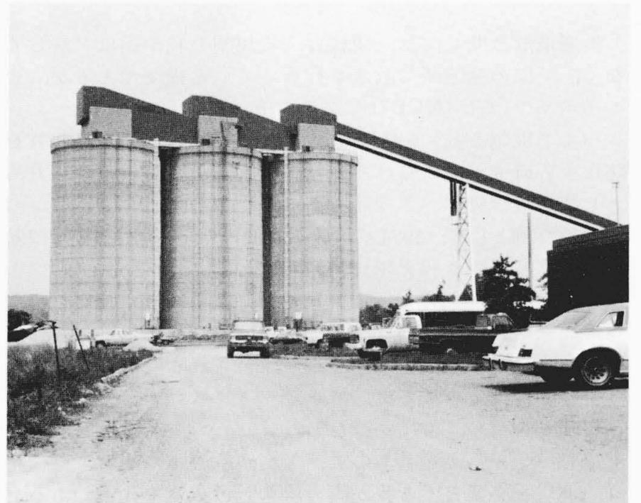
図5 発電所に設置されているサイロ 1972年、米国カンバランド発電所（出力2,600MW）に建設された石炭用サイロを示すもので、容量は1基当たり15,000 sh tnである。
