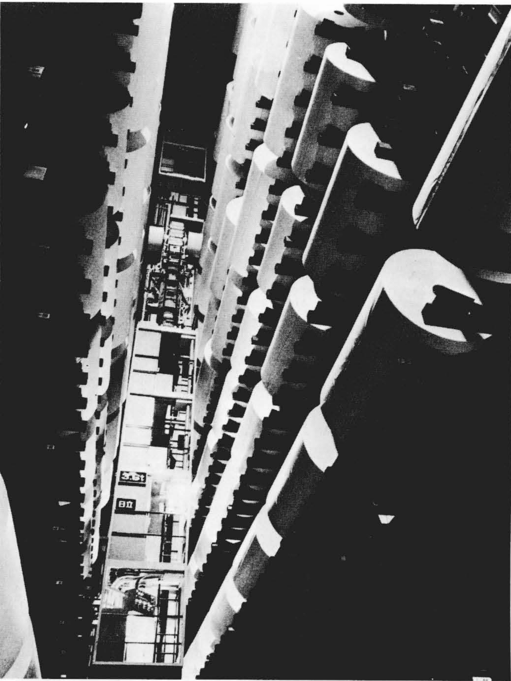
図7 紙ロール保管用倉庫 紙ロールを効率よく保管した倉庫で、庫内は空調されている。
