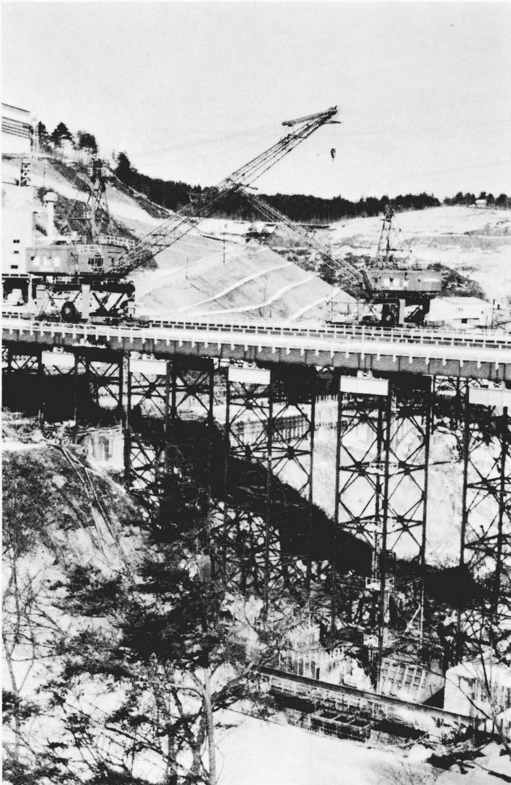
図3 走行式ジブクレーン全景 13.5t×37m走行式ジブクレーン2台が、ダム建設に活躍している。
