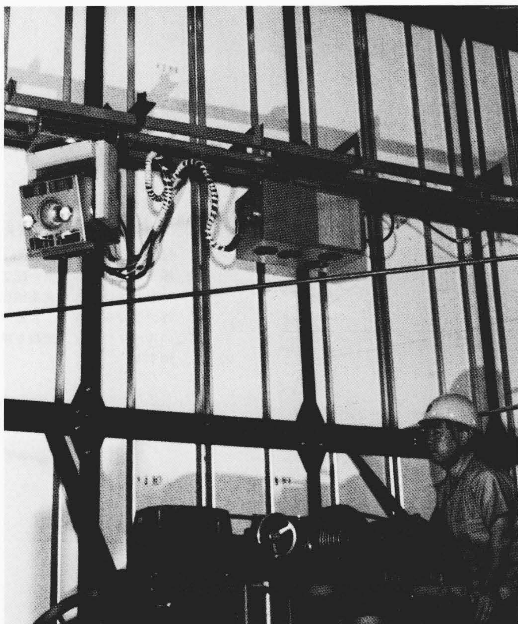
図2 格納容器内点検装置開発機の移動ステーション 前側が低温車(テレビジョンカメラ)、後ろ側がコントロール車である。走行路は、2本の走行レールとトロリチェーンを内蔵するガイドチェーンから成る。移動ステーションは、トロリチェーンにより牽引され走行する。
