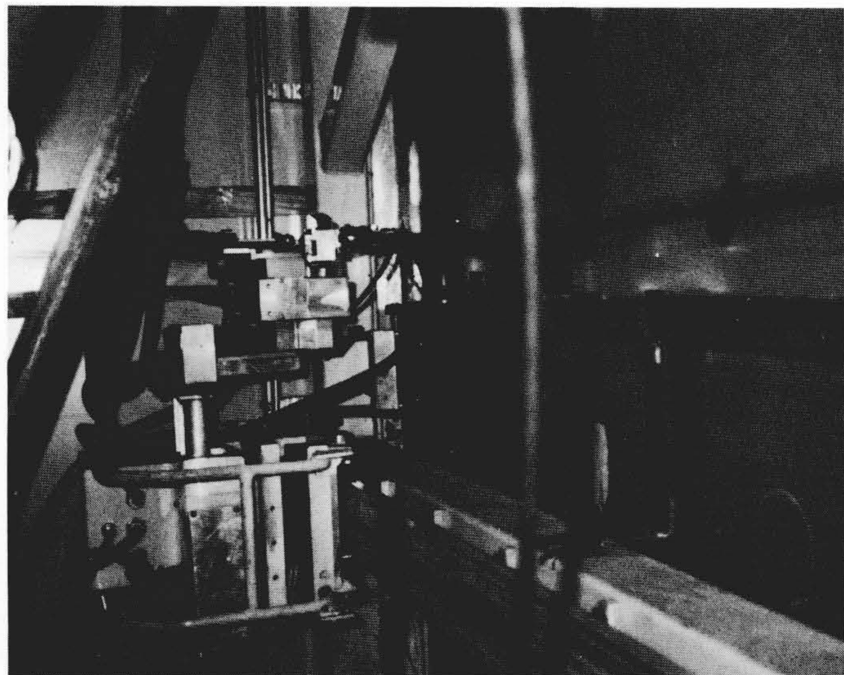
図13 ライニング現地自動溶接(横向き) 日立製作所で独自に開発したワイヤベンディング方式によるミグ溶接で、開先幅6mmの狭開先溶接を行ない効率を上げている。
