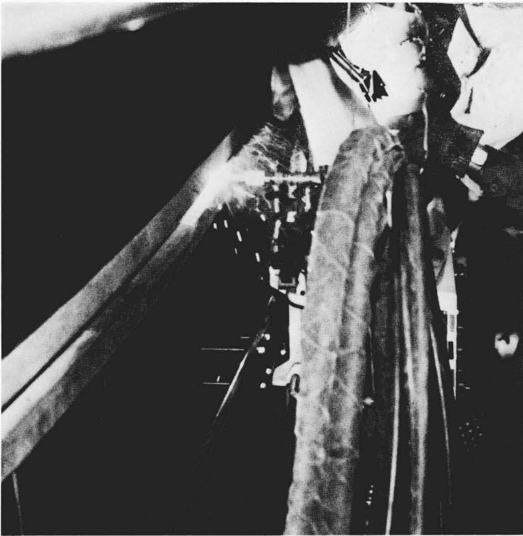
図9 横向きパルスミグ現地自動溶接 日立製作所で独自に開発したパルスミグ電源により、安定で効率の良い横向き及び立て向き溶接自動化が可能となった。本図は現地での施工状況を示す。
