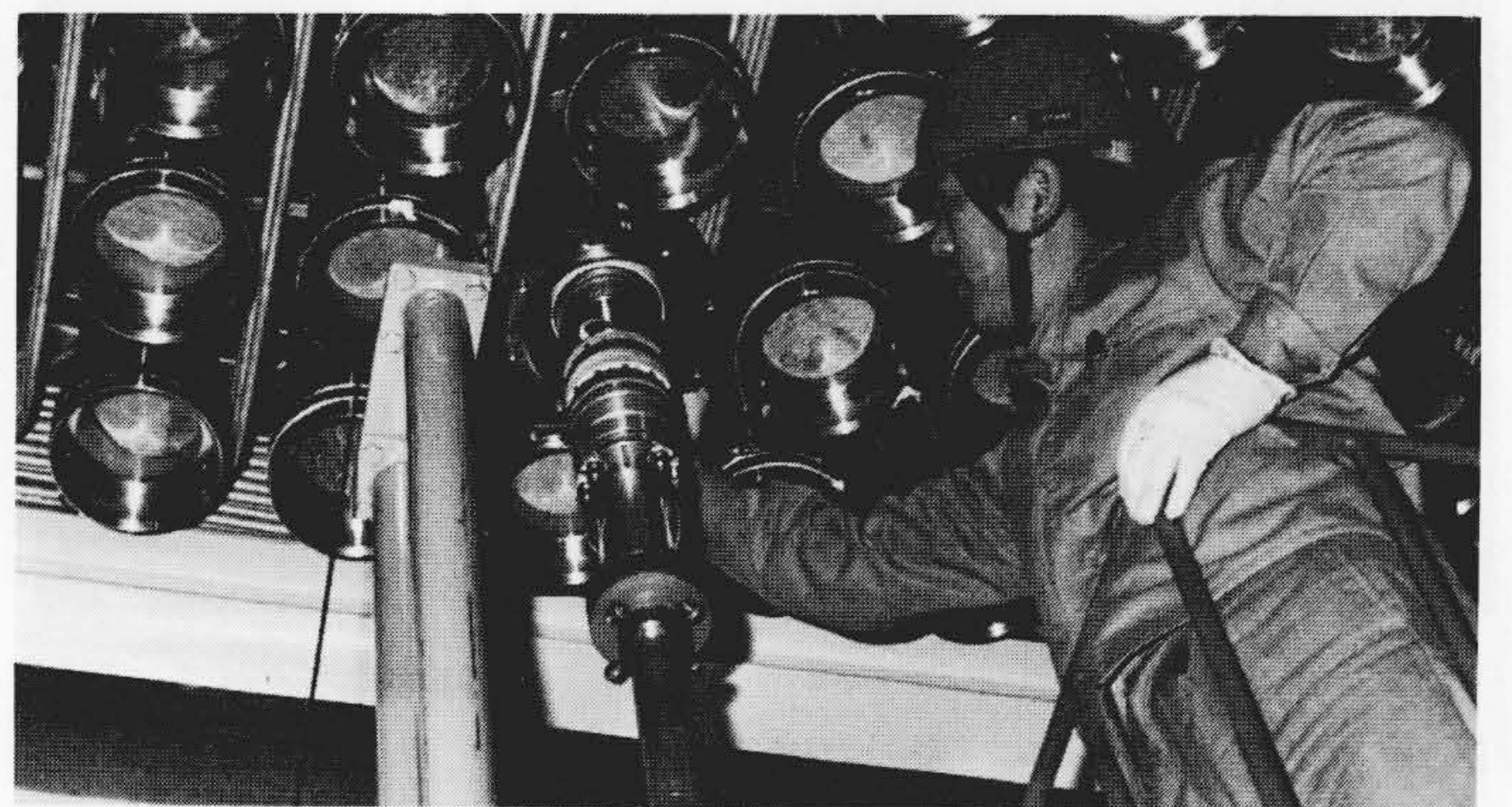
図9 圧力管ロールジョイント近傍の残留応力除去焼鈍作業 「ふげん」サイトでの圧力管ロールジョイント近傍の残留応力除去焼鈍作業状況を示す。
