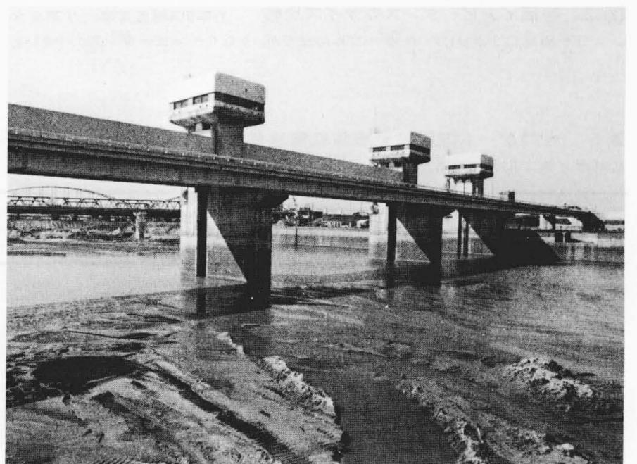
図11 河川水門ゲートの外観 四つの水門用ゲートが, 8基の電動機で駆動される。
