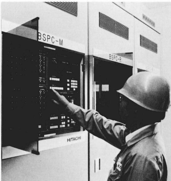
図24 ブロック制御事故波及未然防止システムの主制御装置
