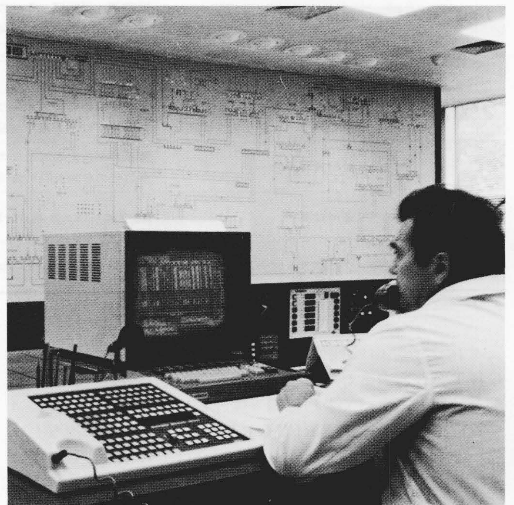
図1 ハンガリー中央給電所自動給電計算機システム 1979年3月、ハンガリーの首都ブタペストで東欧圏近隣諸国間を国際連系線で接続したハンガリー電力系統の総合指令業務を行なう新中央給電所が実用運転に入った。
