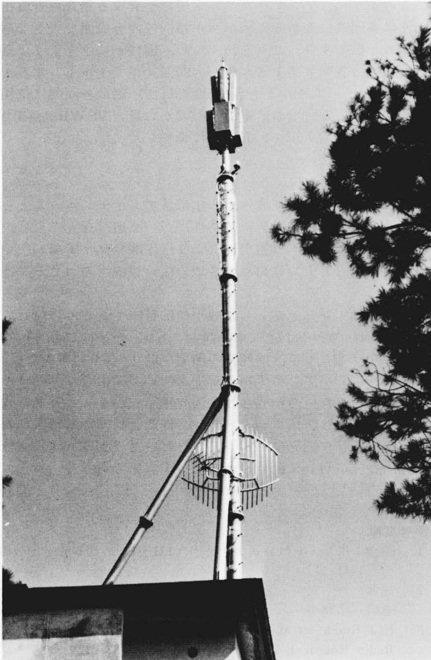
図9 小電力局指向性アンテナの外観 上段のアンテナは従来の双ループアンテナ、下段が広帯域4ダイポールアンテナによる4チャンネル共用アンテナ(566~758MHz)である。
