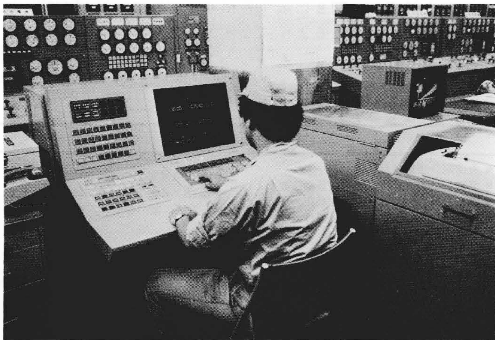
図4 オペレータコンソール外観 自家用発電設備を集中監視し、制御するオペレータコンソールの外観を示す。
