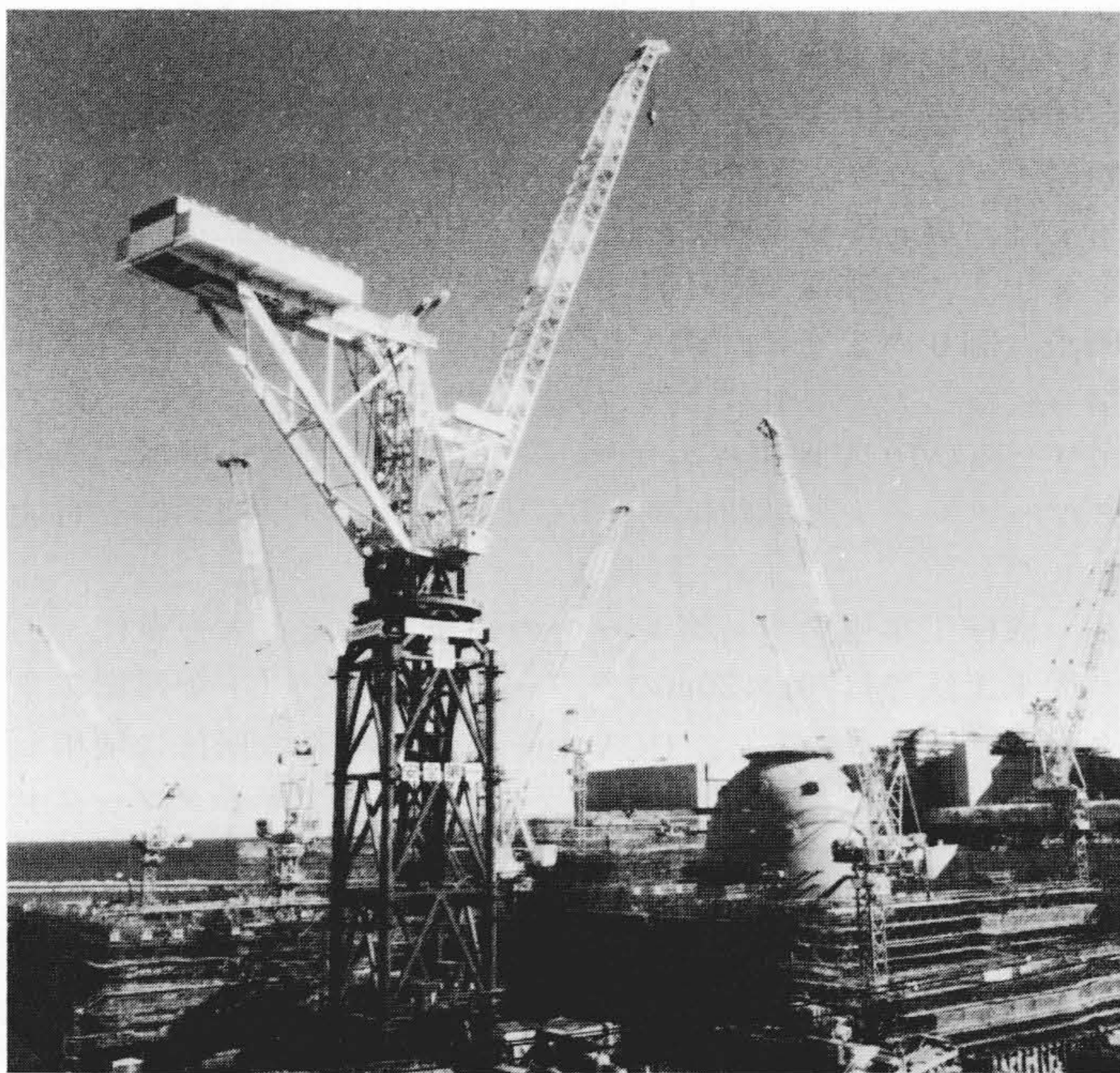
図7 機械工事用130tタワークレーン 機械工事用タワークレーンを我が国最初に130t級に大容量化し、PCV、その他機器のプレハブ化率向上と搬入作業の効率化を図った。
